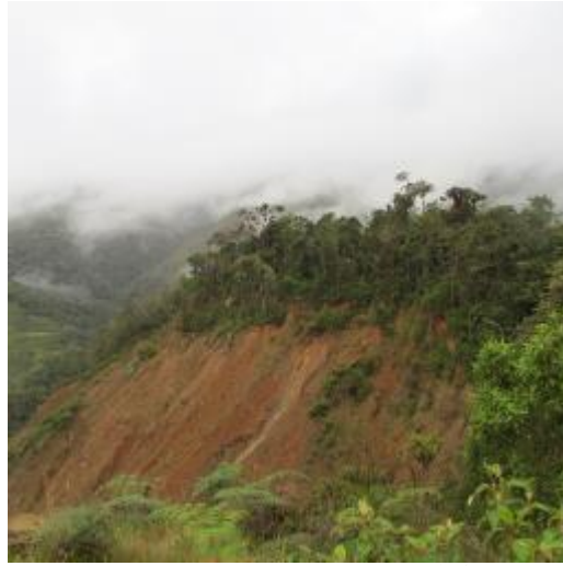
Foto 15. Derrumbe. El Placer
