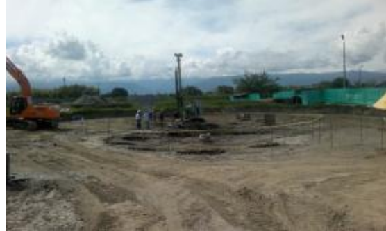
Cimentación para Filtro Percolador y piloteo para cimentación de Clarificador PTAR Tuluá
