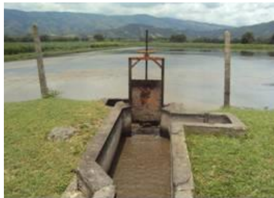
En esta toma se observa la estructura de entrada al sistema de tratamiento de aguas residuales del ingenio Carmelita S.A.
