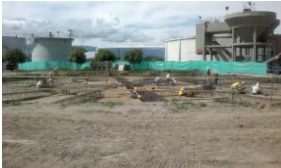
Cimentación para Filtro Percolador y piloteo para cimentación de Clarificador PTAR Tuluá
