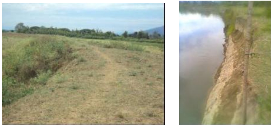
Panorámica diques de contención río Cauca
