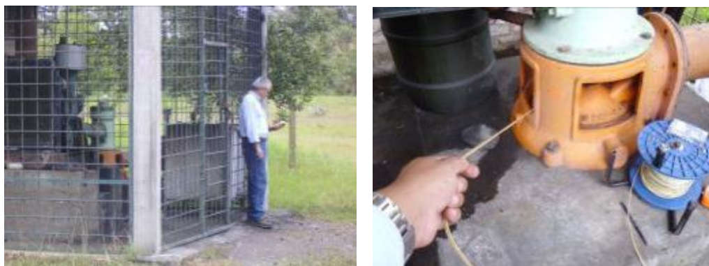
Medición de niveles y lectura de contadores en campo.
