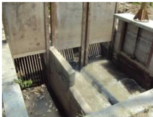
Estructura donde inicia el sifón invertido sobre el río Tuluá. En la Foto 2 se aprecia la estructura de separación del sifón invertido.
