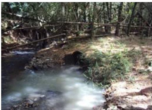
Descarga colector Zúñiga Municipio de Caicedonia
