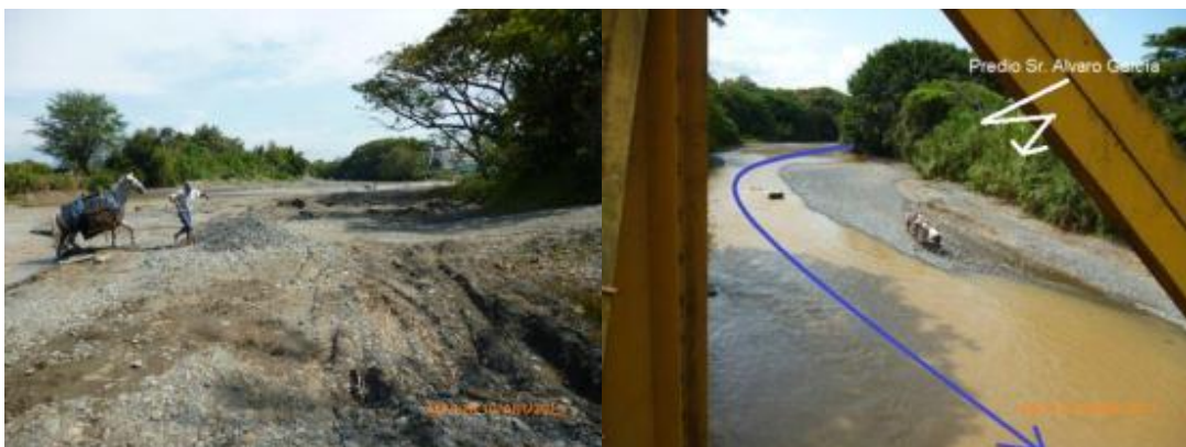
Extracción de material de arrastre Río Bugalagrande
