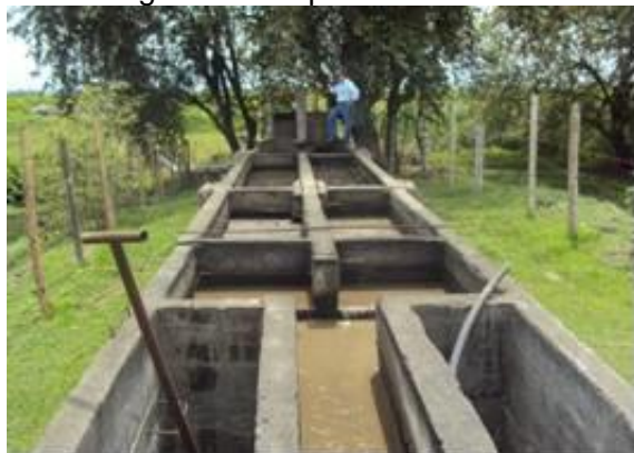
En esta toma se observa la estructura de entrada al sistema de tratamiento de aguas residuales del ingenio Carmelita S.A.
