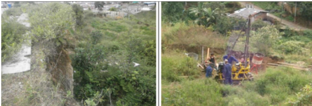
Obras para el control de Erosión Municipio de Sevilla
