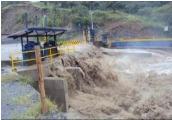
Bocatoma del río Tuluá, a la altura del Jardín Botánico, donde se verificó buen comportamiento de las estructuras.
