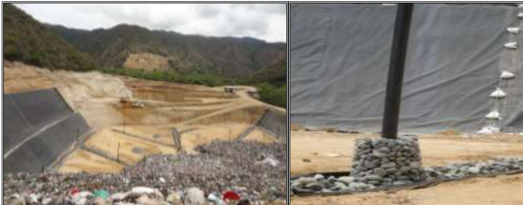
Adecuación del vaso C- Celda C2T2.
