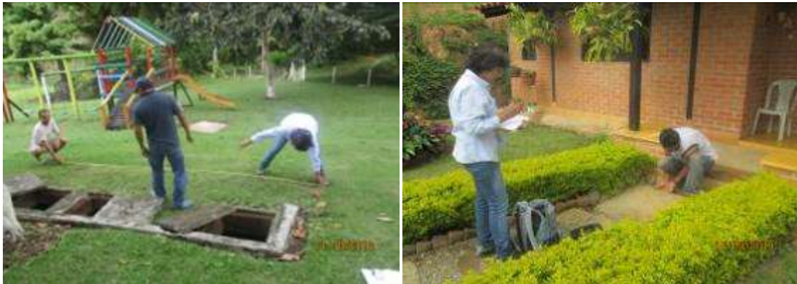
Foto 25 y 26. Seguimiento a sistemas de tratamiento de aguas residuales
