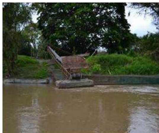
Paladrago a margen izquierda del rio (3.850468,-76.373802)
