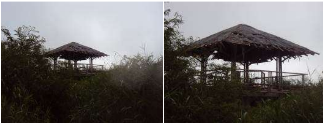
Trabajos de limpieza
