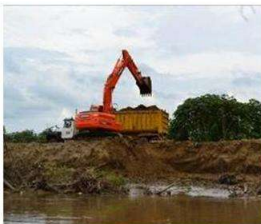
Trabajos de Maquinaria extracción de material de préstamo del Río Cauca
