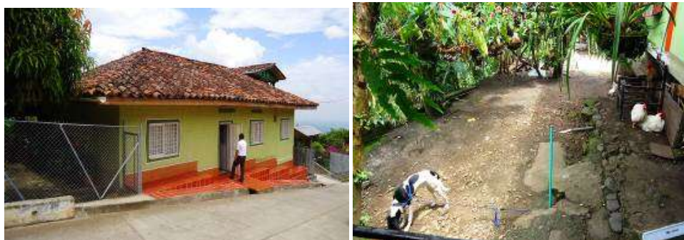
Viviendas visitadas en el Corregimiento el Castillo, municipio de Cerrito
