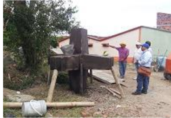
Hexápodos y Obras de fijación de orilla de la margen izquierda del río La Vieja
