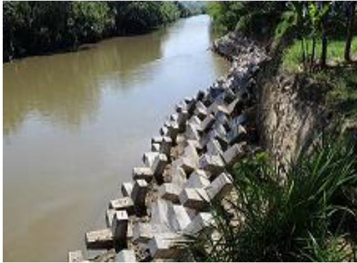
Hexápodos y Obras de fijación de orilla de la margen izquierda del río La Vieja
