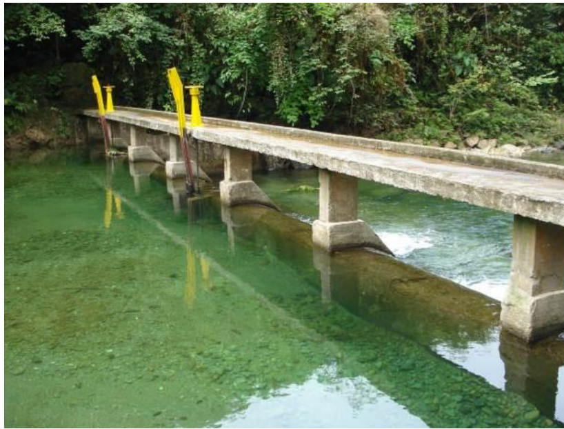
Foto 41. Estructura de captación o bocatoma del acueducto de Buenaventura, sobre el Río Escalerete y San Cipriano
