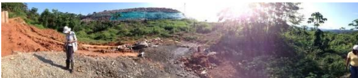
Foto 44. Se aprecia la altura de residuos sólidos en el área de contingencia
