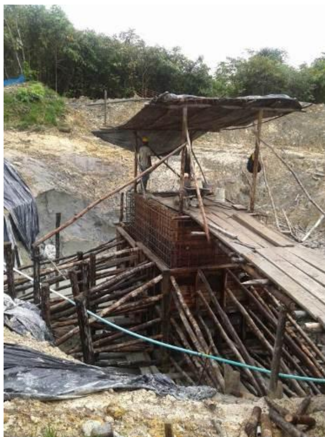
Construcción estación de bombeo de aguas residuales No. 1. (EBAR No. 1)
