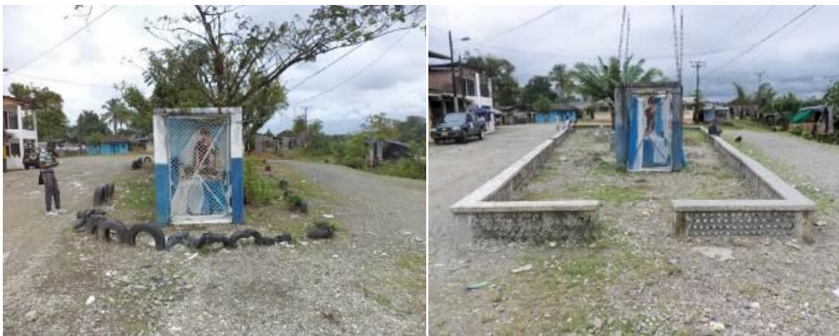
Foto 59. Avance proceso de construcción Parque Ecológico
