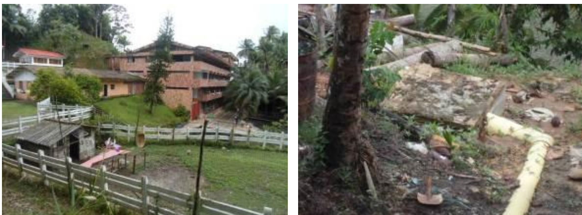
Foto 13. Infraestructura turística, manejo y tratamiento de vertimientos Hotel Maguipi
