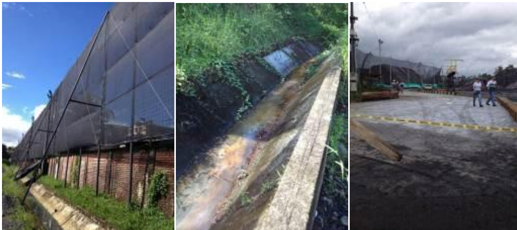
Foto 52. Construcción de infraestructura para patios de carbón
