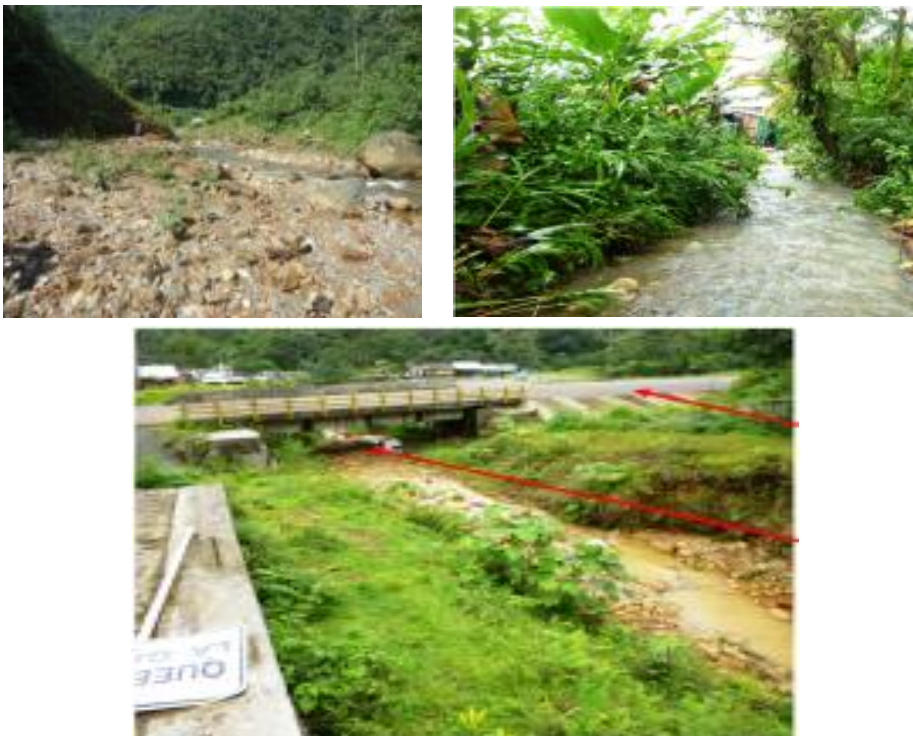
Foto 38. corredor vial entre Zaragoza y Triana
