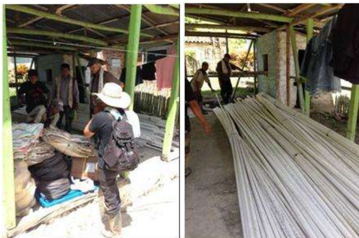
Registros de preparación para iniciar las labores de construcción
