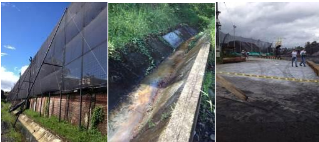
Foto 52. Construcción de infraestructura para patios de carbón
