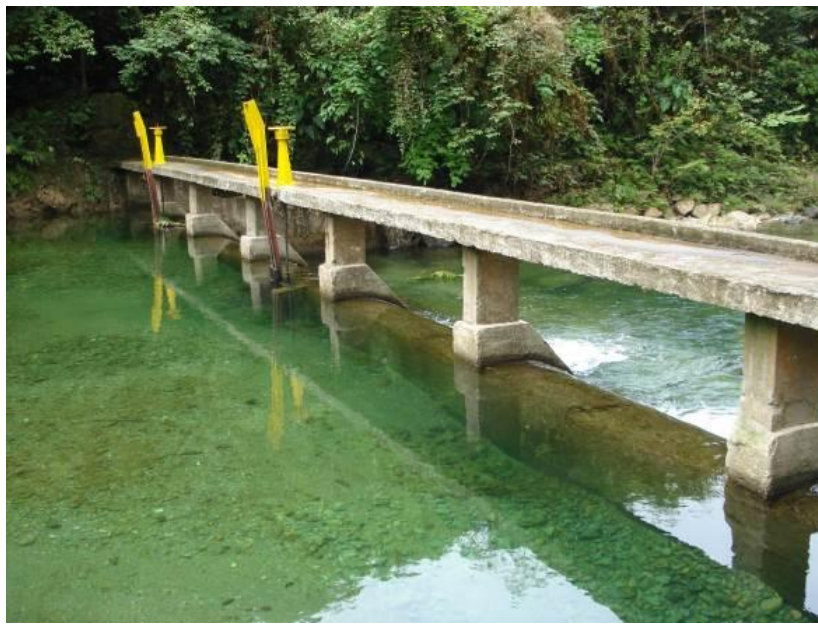
Foto 41. Estructura de captación o bocatoma del acueducto de Buenaventura, sobre el Rio Escalerete y San Cipriano
