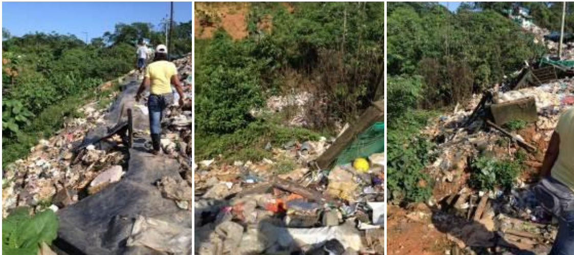
Foto 46. Saturación de residuos dispuestos los cuales están cayendo al área de la ampliación del vaso No.2 que no ha sido construida.
