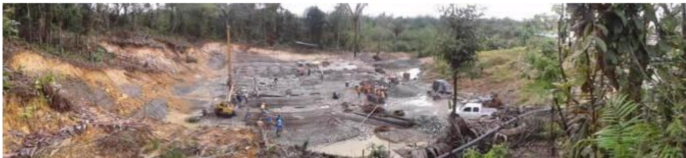
Panorámica General de la Construcción de la PTAR Macroproyecto de Vivienda de Interés Nacional San Antonio
