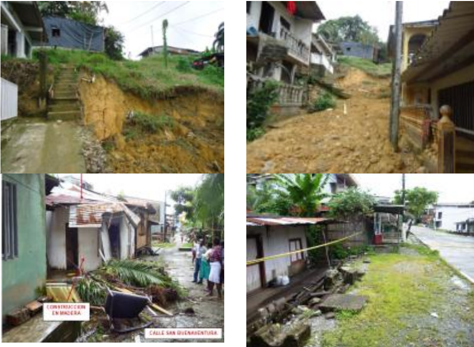
Foto 39. Deslizamiento de ladera, Barrio El Triunfo - Buenaventura
