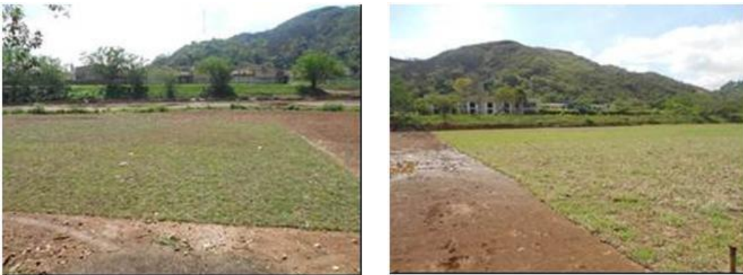
Recuperación del volumen útil y empradización de taludes
