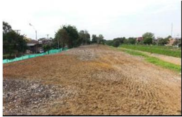
Área libre de escombros
