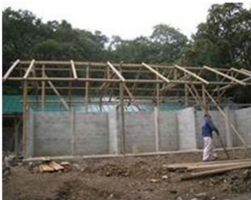
Módulos de reciclaje en construcción
