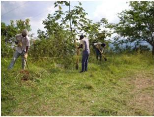
Labores parciales de aislamiento de protección predio Finango, cuenca río Yumbo. Predio público de Alcaldía de Yumbo
