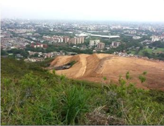
Retiro de la capa de material estéril ( carbonilla ) que cubría la ladera
