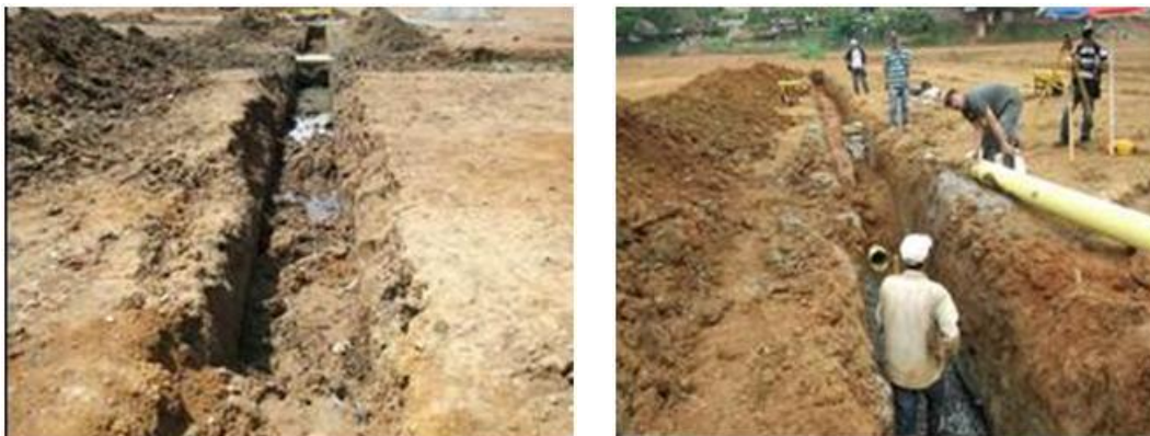
Apertura de zanjas e Instalación de tuberías
