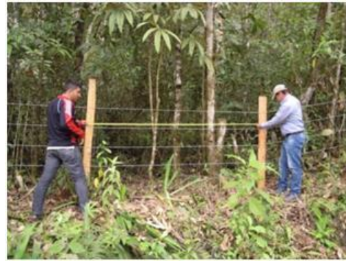
Labores de medición de obras por parte de Supervisión CVC e Interventoría Universidad Distrital.
