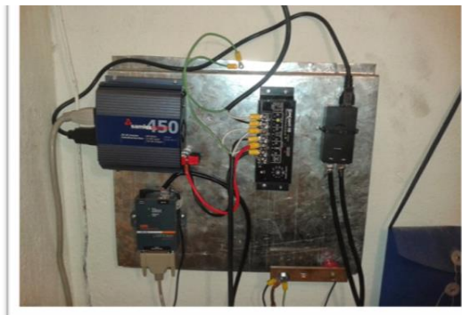
Estación Hospital Universitario después
