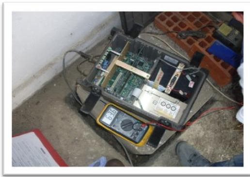
Estación Hospital Universitario antes
