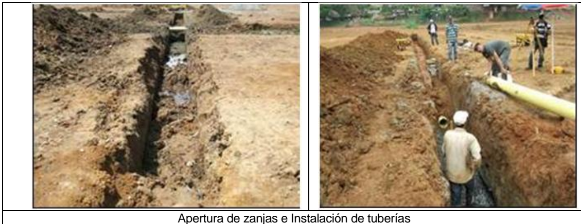
Apertura de zanjas e Instalación de tuberías
