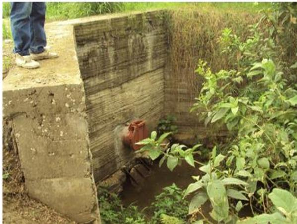
Foto: Obra en concreto sobre la cual se ha instalado compuerta y tubería, que impiden el libre flujo de aguas del humedal Timbique hacia el río Bolo y del remanso del río hacia el humedal.
