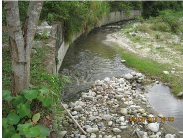
Foto. Bocatoma del acueducto No 3 en el cauce del río Frayle con colmatación
