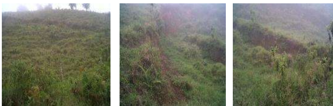
Recorrido de monitoreo identificación de situaciones de riesgo de la vía El Dovio- Bitaco Se observa agrietamientos profundos por el desprendimiento en masa,
