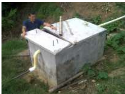
Seguimiento medida preventiva construcción de sistema de tratamiento aguas mieles de café-Roldanillo.
