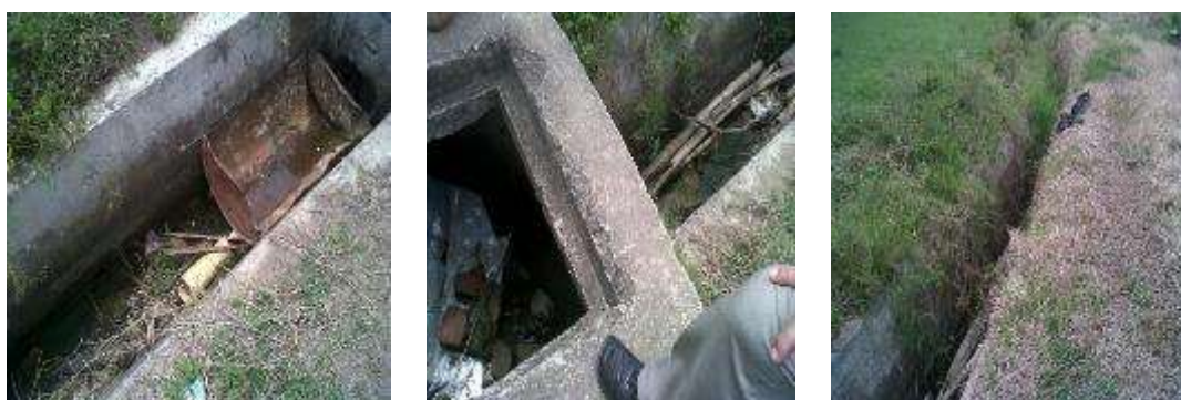
Recorrido de monitoreo identificación de situaciones de riesgo en el Barrio Hector Urdinola, ubicado en el municipio de El Dovio,
