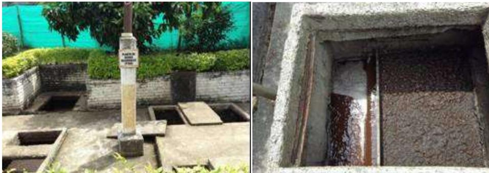
En estas fotos se observa el filtro anaerobio del sistema de tratamiento de aguas residuales de la planta de sacrificio del municipio de Tuluá, administrada y operada por la empresa *FRIGOTIMANÁ*.
