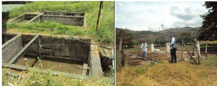
En las fotos se observa los filtros anaerobios de flujo ascendente y los lechos de secado de la granja porcicola El Rhin municipio de Riofrío.
