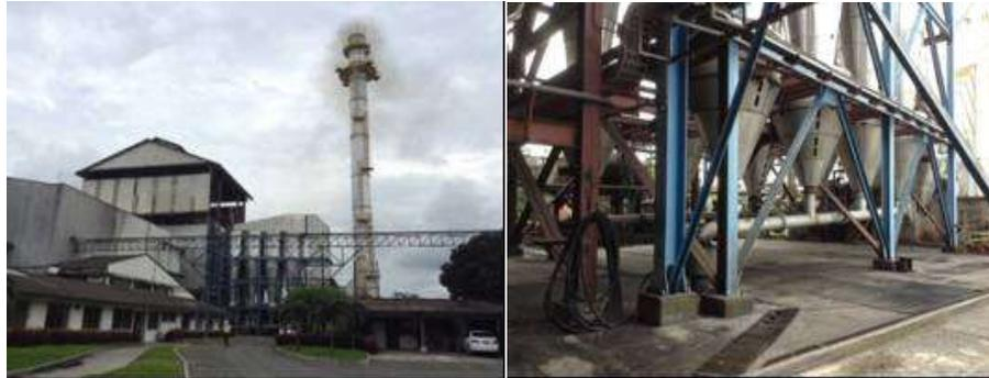
Se aprecia una vista general de la fuente fija de emisiones atmosféricas del ingenio San Carlos y el sistema de control compuesto por dos líneas de 4 ciclones cada una.
