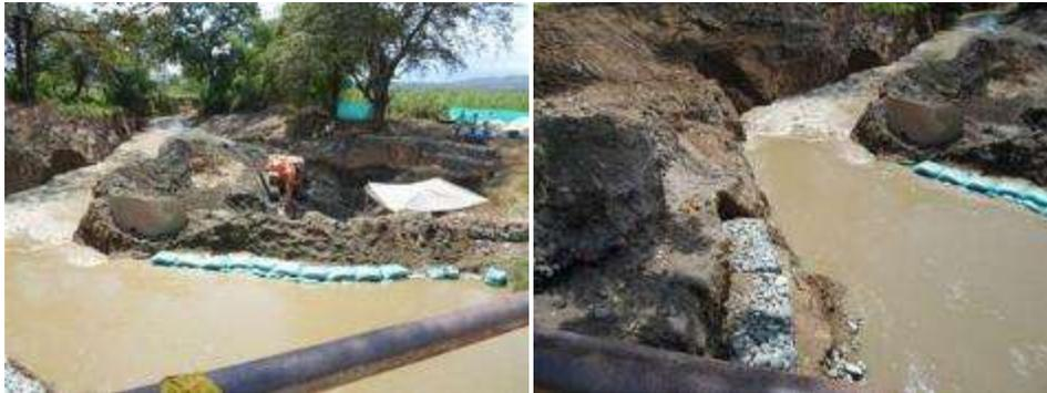
Detalles fotográficos del desplazamiento de obra marginal y las obras posteriores de recuperación y estabilización de orillas.
