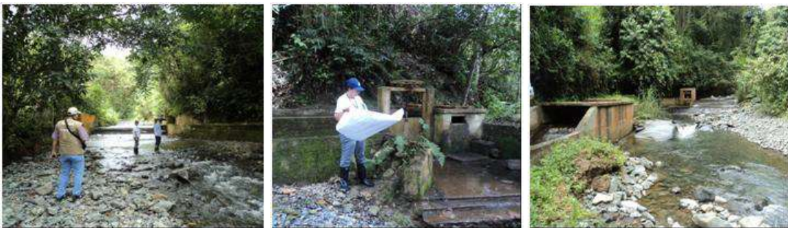
Seguimiento a Acueductos Rurales San Jose y El Manantial – Municipio de Buga
