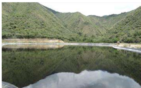
La laguna de contingencia No. 2 tiene alrededor de 120000 m3 de lixiviados almacenados
