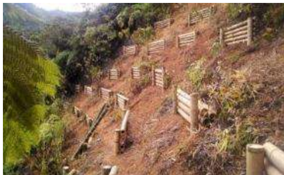
Fundación Acoc - Obras de bioingeniería
