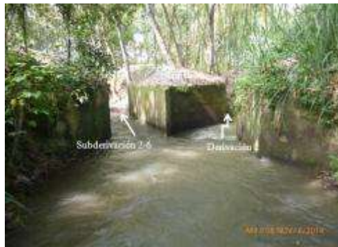
Foto de derivación 2 y Captación de la subderivación 2-6
