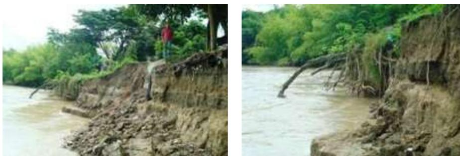
Se evidencia el proceso de erosión lateral sobre la orilla izquierda del río La Vieja a la altura del barrio Guayacanes en el Municipio de Cartago; se observa perfil arenoso no cohesivo, escombros y muro expuesto antes de dar inicio a las obras de protección de orilla.
