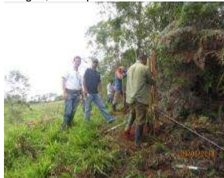
Vista de predio en desarrollo de labores de instalación de aislamientos de protección.
