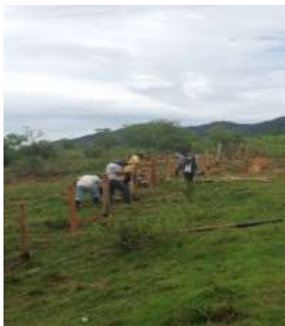
Obras de control de erosión en Restrepo.
