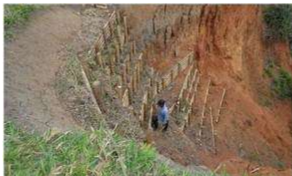
Área intervenida afecta por el movimiento en masa Quebrada La Italia, Predio La Italia
