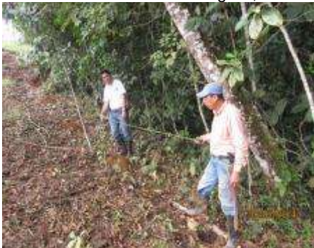
Vista de predio antes de iniciar labores de instalación de aislamientos de protección.
