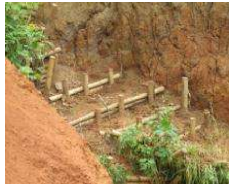
Mantenimiento de trinchos
