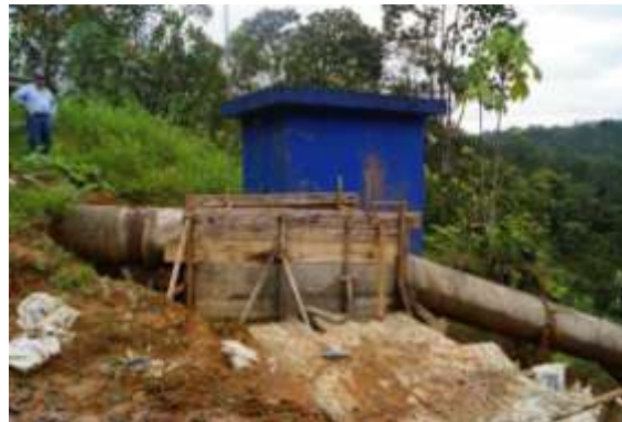
Caseta ubicación de macromedidores a la salida planta de tratamiento
