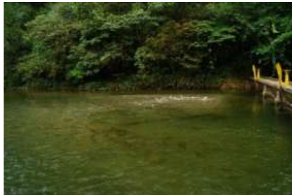
Depósito de sedimentos aguas arriba del dique o bocatoma principal
