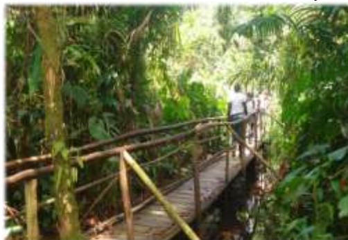
San Cipriano- Adecuación de Senderos Ecoturístico
