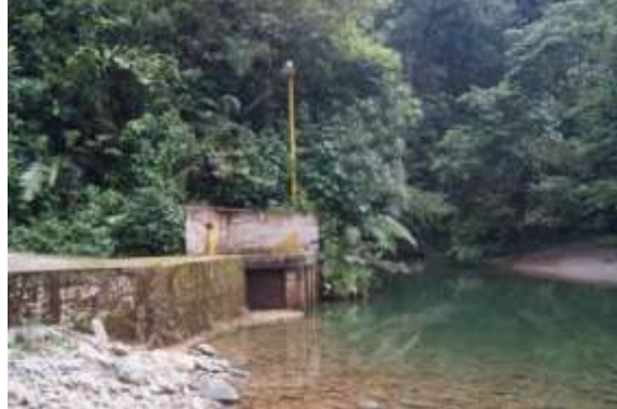
Bocatoma secundaria acueducto de Buenaventura, sobre el Rio Escalerete
