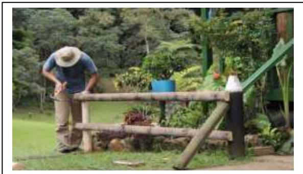
Reparaciones CEA La Teresita
