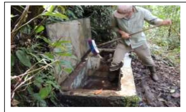
Mantenimiento acueducto CEA La Teresita
