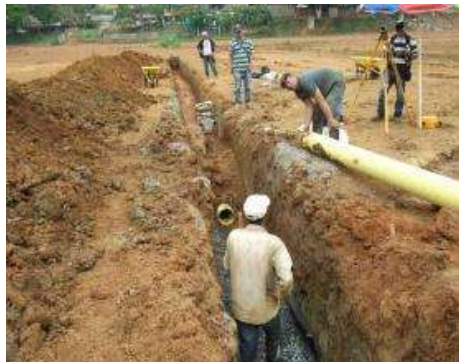
Apertura de zanjas e instalación de tubería
