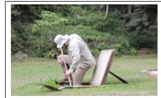
Mantenimiento alcantarillado CEA La Teresita
