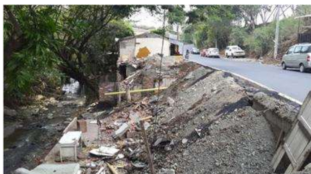
Monitoreo de escenarios de riesgo – Seguimiento a inundaciones y remoción en masa – reubicación de franjas forestales protectoras río Arroyohondo del municipio de Yumbo
