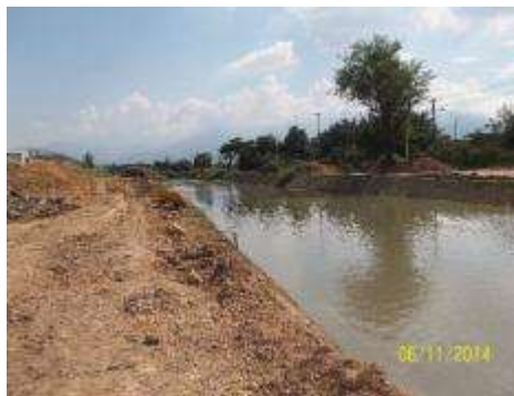
Descolmatación del Humedal
