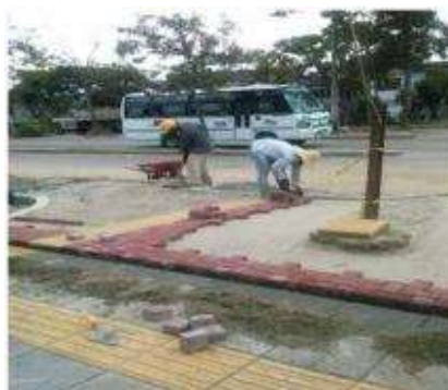
Construcción andenes y senderos
