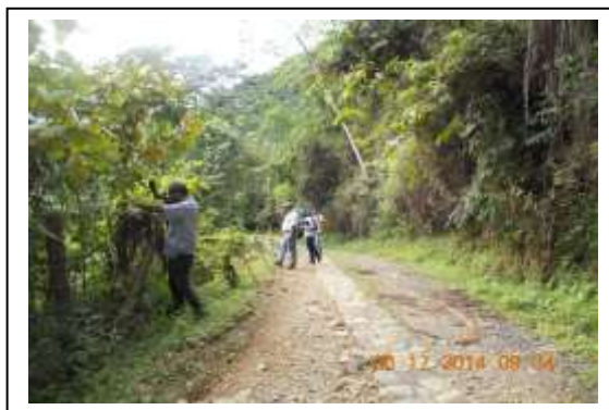
Sitio del deslizamiento en la vía.
