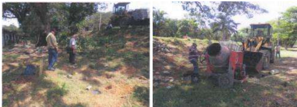
Fotos de inyección de las cavernas de hormiga arriera
