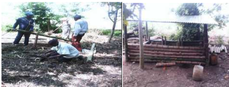
Composteras construidas y en funcionamiento en el área de influencia del humedal el Cabezón
