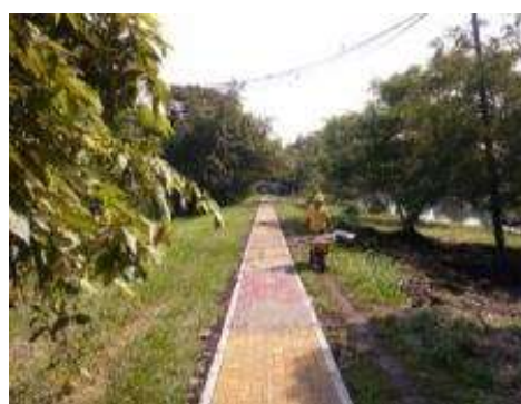
Sendero construido en adoquín
