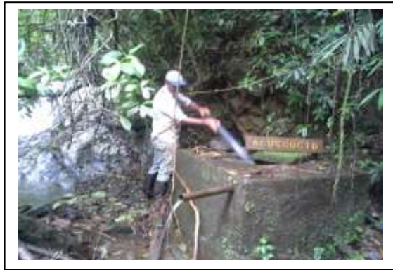
Mantenimiento acueducto CEA El Topacio
