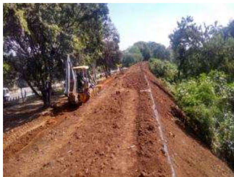
Taludes en la cara seca del dique entre abscisas K0+180 A K0+140
