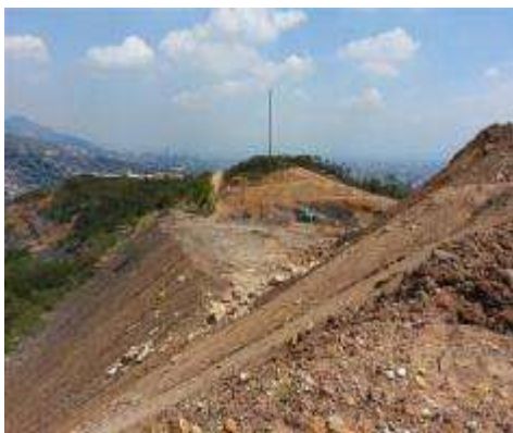
Vista del sector noroccidental de la obra; se aprecia la remoción del material Estéril de carbón realizado sobre las laderas del cerro de la bandera
