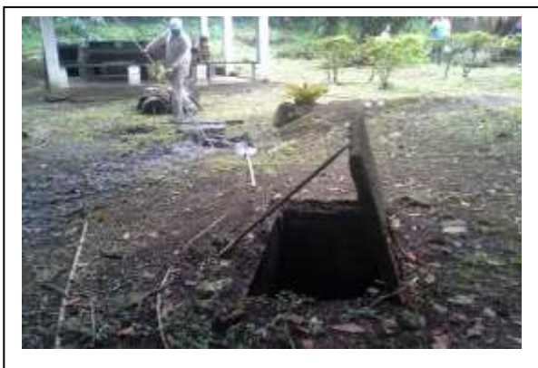
Mantenimiento alcantarillado CEA El Topacio
