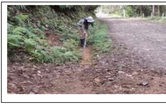
Mantenimiento cunetas CEA La Teresita
