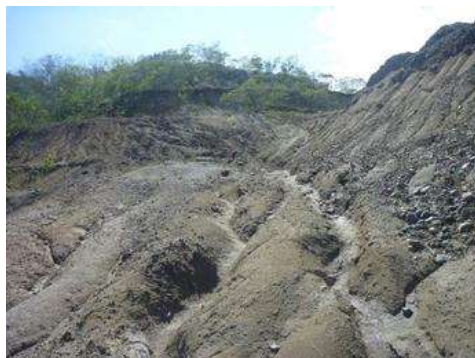
Cárcavas formadas por aguas de escorrentía. Titulo JE2-08301X. Manejo inadecuado
