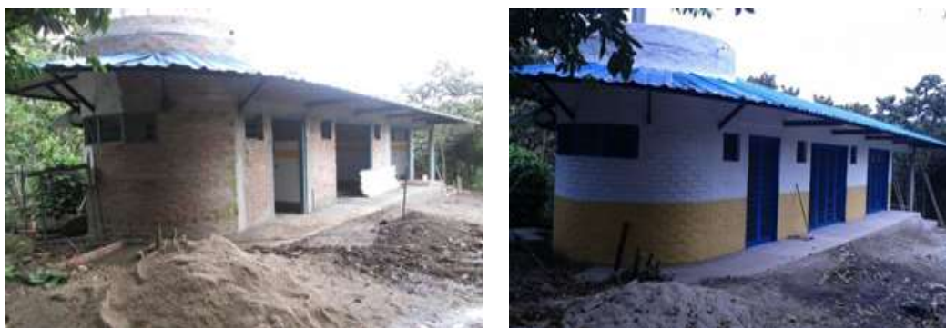
Obra civil al inicio y al final.
