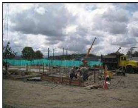
Construcción base de tanques
