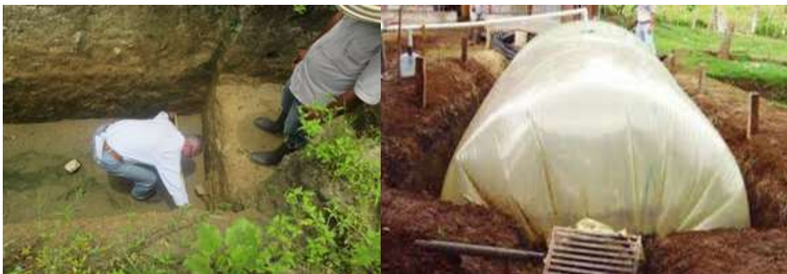
Inicio y final de la instalación.
