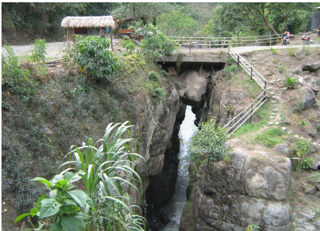
FOTO No.1 Puente Piedra, Municipio de Ginebra. Tomada: DAR Centro Sur
