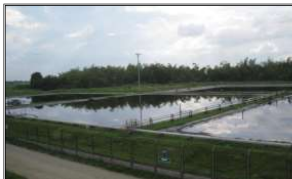
Foto 383. PTL – Almacenamiento de vinaza - Destilería Alcohol Carburante Ingenio Manuelita
