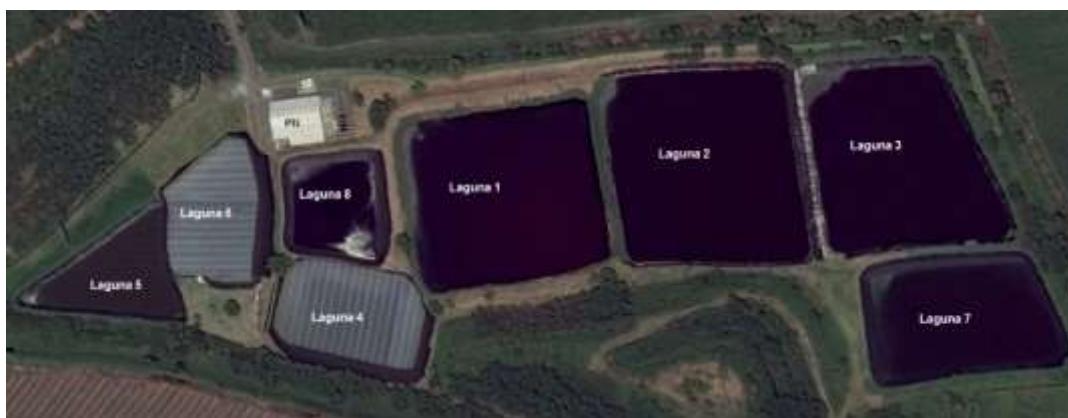
Foto 403. Planta de tratamiento de Lixiviados de Navarro
