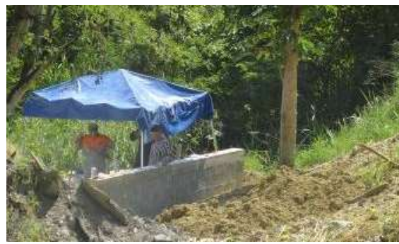
Foto 380. PTL – Construcción muro de protección pozos de monitoreo-Relleno Sanitario Regional Presidente
