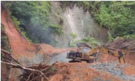
Foto 39. Retroexcavadora destruida en la cuenca del pacífico – Bajo Anchicayá
