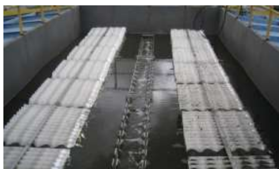
Foto 386. Cambio placas del sedimentador UASB - Destilería Alcohol Carburante Ingenio Providencia
