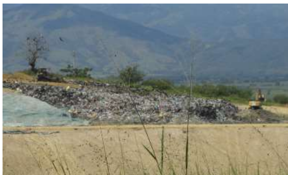
Foto 379. PTL – Frente de operación - Relleno Sanitario Regional Presidente
