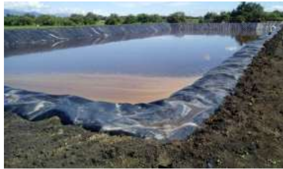
Foto 389. Reservorio No. 4 - Destilería Riopaila
