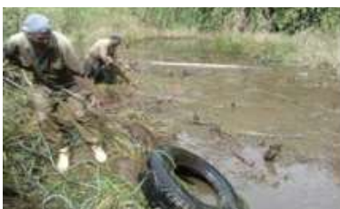
Foto 256. Limpieza y extracción de vegetación y basuras. Archivo CVC 2017.
