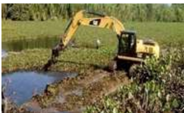
Foto 253. Limpieza y extracción mecanizada. Archivo CVC 2017.
