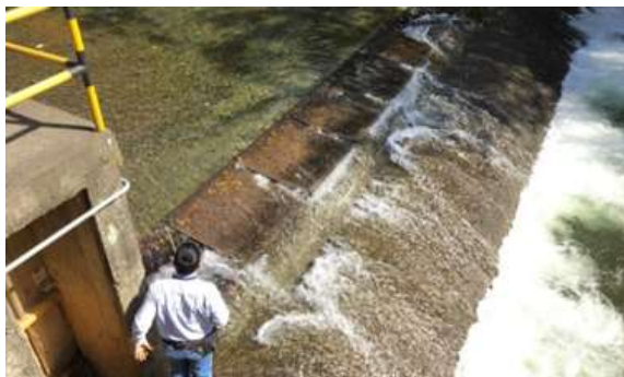
Foto 117. Captación río Cali 1 – EMCALI
