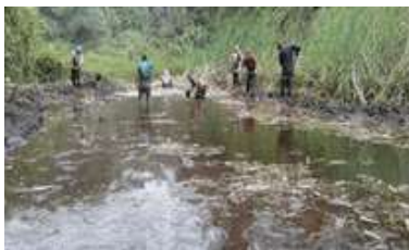
Foto 259. Limpieza y extracción de sedimentos de manera manual. Archivo CVC 2017.
