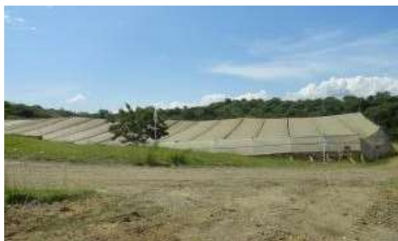
Foto 381. PTL – Celda de seguridad La Esperanza – ajuste de cubierta
