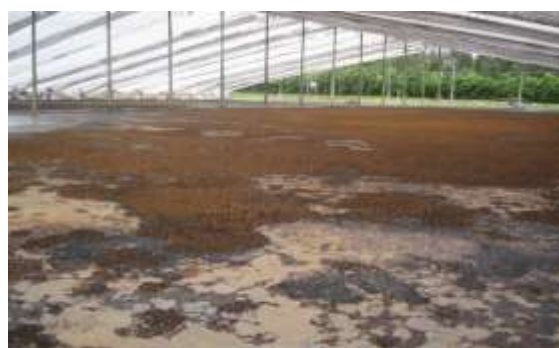
Foto 387. Reservorio de vinaza con lodos - Destilería Alcohol Carburante Ingenio Providencia
