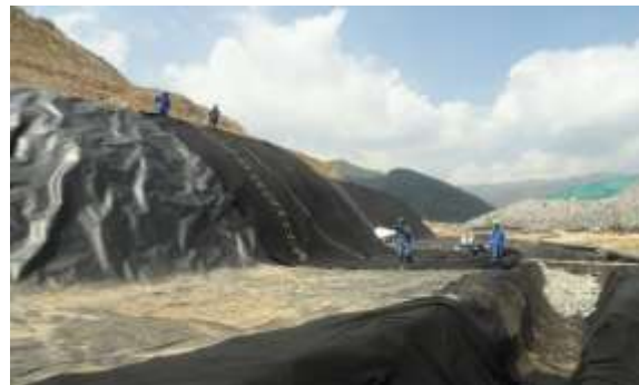
Foto 378. PTL – Adecuación vaso 8 Relleno Sanitario Colomba – El Guabal
