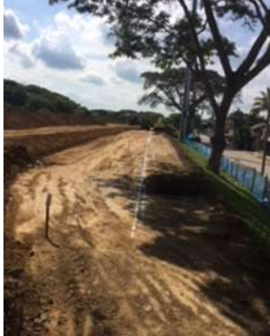
Foto 439. Excavación a máquina de material incompetente Sector 1
