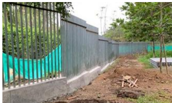
Foto 296 Cerramiento Humedal Cañasgordas
