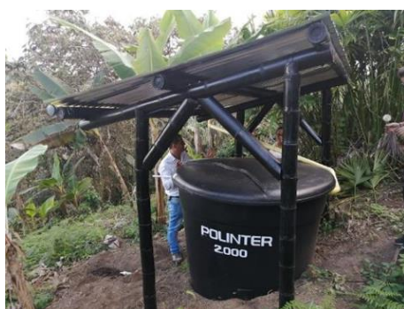
Foto 119. . Instalación de reservorios de aguas lluvia, vereda Tarritos, Argelia.
