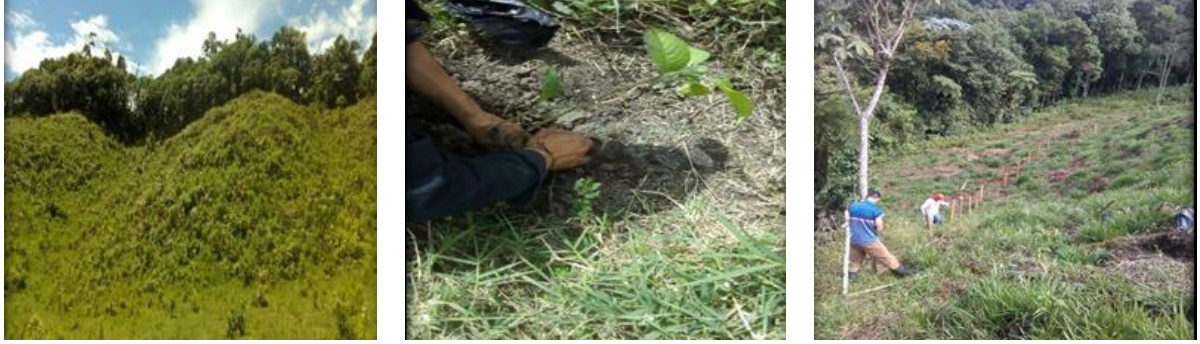
Foto 116. Antes, Durante y Después. Aislamiento de Protección. Predio Las Mercedes. Acueducto La Cabaña. Municipio de Guadalajara de Buga.
