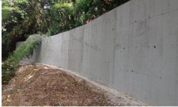
Foto 279 Muro en concreto sobre caisson para protección orilla Bella Suiza
