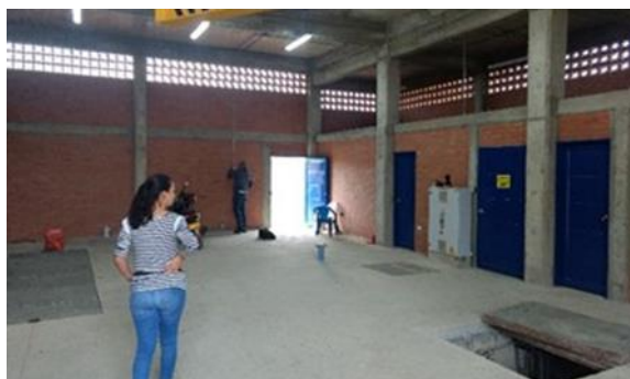
Foto 97. Puesta en marcha estación de bombeo, municipio de Tuluá – DAR Centro Norte.
