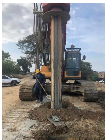
Foto 222. Construcción de columnas pre-excavadas.
