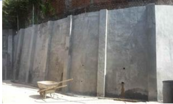
Foto 280 Pantalla en concreto con anclajes para estabilización talud Juana Caicedo
