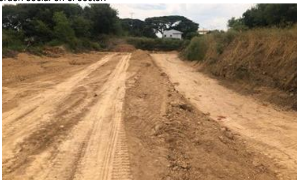
Foto 221. Realce de dique.
