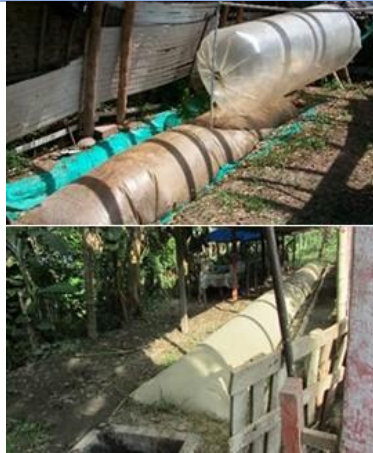
Foto 11. Biodigestores en granjas porcícolas en territorio BRUT.
