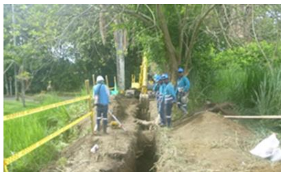
Foto 98. Construcción interceptores PTR Palmira – DAR Suroriente.
