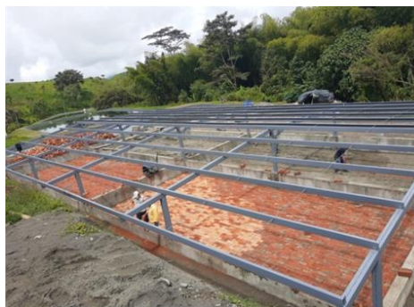
Foto 108. Construcción de lechos de secado en la PTAR del municipio de Versalles.
