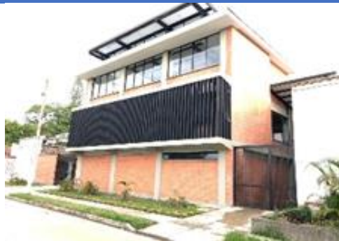
Foto 230. DAR Sur Oriente. Fachada principal
