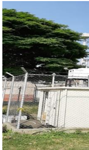
Foto 202 Instalación de equipos Estación de Calidad del Aire de Palmira
