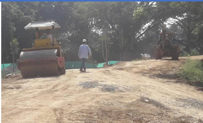
Foto 220. Obra en sector Navarro.
