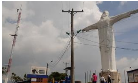
Foto 282 Cámara instalada en Cerro Cristo Rey
