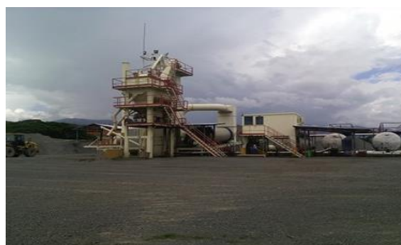
Foto 46. Planta de asfalto INTRAME y Planta de triturado en funcionamiento. PISA – Proyectos de Infraestructura S.A.
