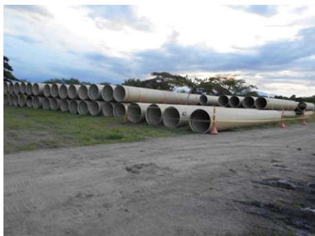
Foto 107. Aprestamiento de materiales y construcción del cerramiento en el predio de la PTAR.
