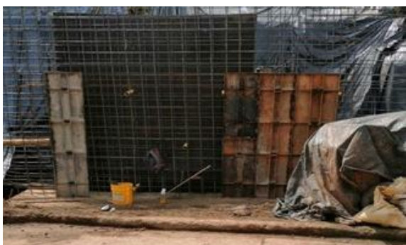
Foto 271 Excavación para el muro de contención Brisas de la Chorrera
