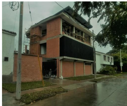
Foto 2. Construcción sede DAR Suroriental-Palmira.
