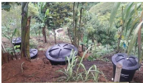
Foto 109. Sistemas de tratamiento de vertimientos originados en el beneficio de Café, El Águila.
