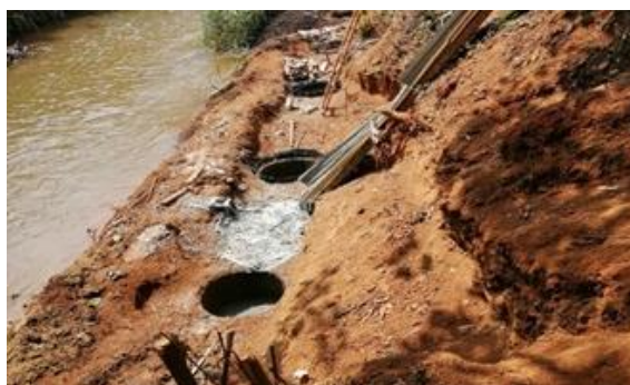
Foto 272 Construcción dique provisional desvío del río Meléndez
