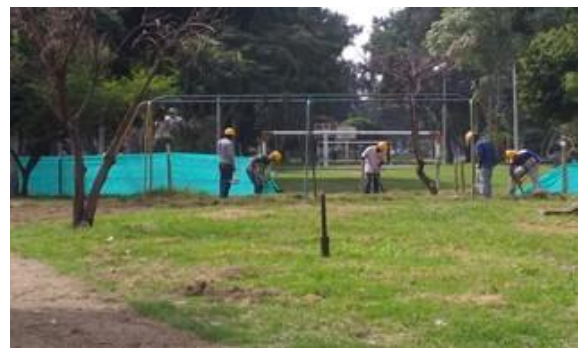
Foto 294 Construcción de cerramiento perimetral
