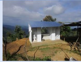
Foto 21. Batería sanitaria: incluye ducha, lavadero y baño. Sistema de Tratamiento de Aguas Residuales para la comunidad indígena de Mateguadua en el municipio de Florida.
