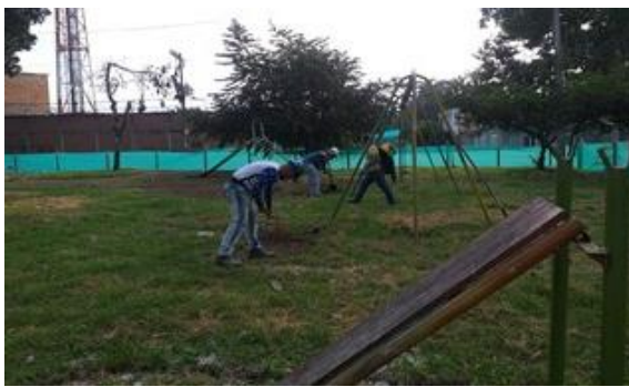
Foto 293 Excavación y retiro de material
