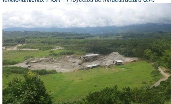
Foto 48. Panorámica de la Planta de Triturado. ARISOL S.A.S.
