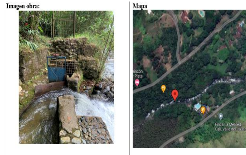
Figura 13. Descripción obra hidráulica 2
