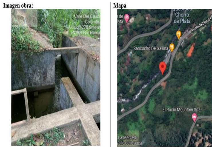
Figura 14. Descripción obra hidráulica 3
