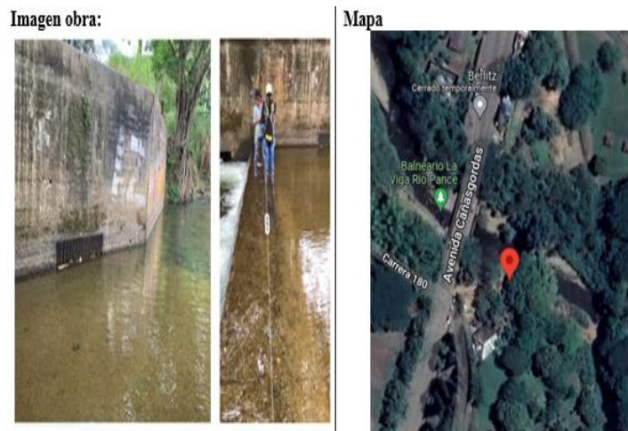
Figura 15. Descripción obra hidráulica 4
