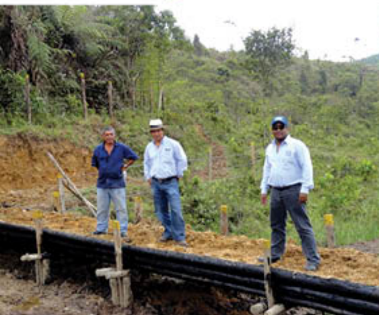
Vista trabajos de aislamientos
