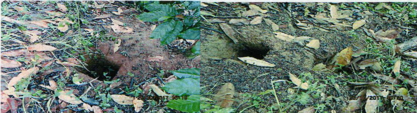
Ahoyado para poste de aislamiento y para cerca viva
