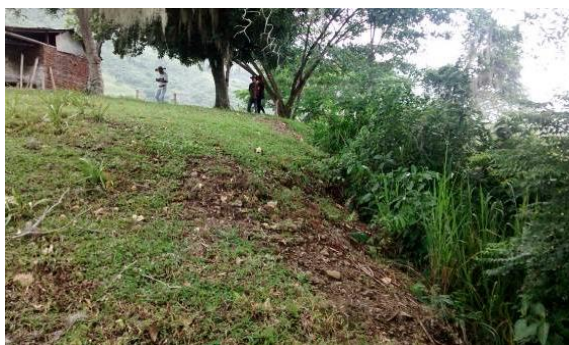
Foto 151. Riesgo por inundación crecientes súbitas - Predio La Luisa, vía corregimiento de Ceilán Municipio Bugalagrande. Archivo CVC 2016
