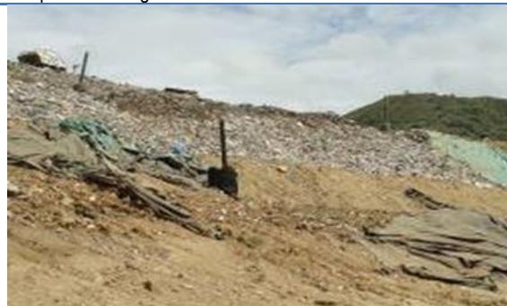
Foto 119. Construcción Filtros Relleno sanitario regional Colomba – El Guabal. Archivo CVC 2016
