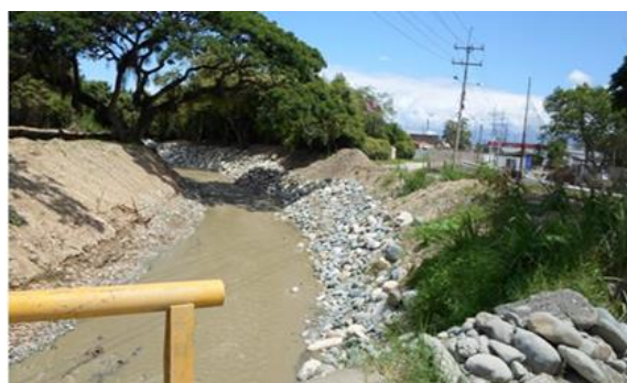
Foto 148. Enrocado Puente San Benito - Quebrada La Ribera - Municipio Tuluá. Archivo CVC 2016
