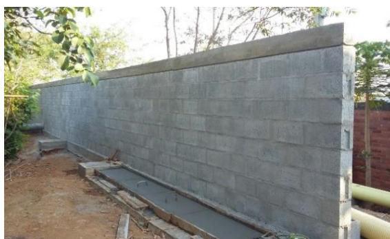
Foto 164. Muro en mampostería para protección de la PTAR del Caney
