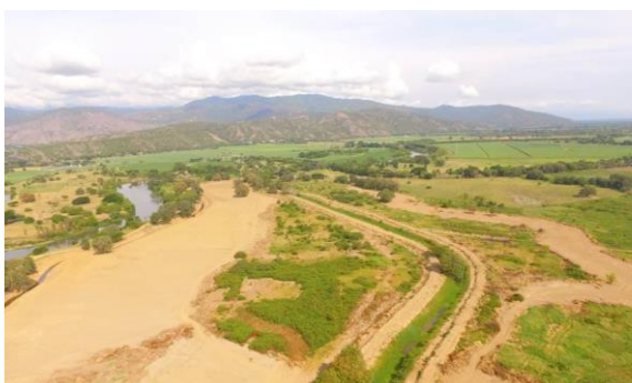
Foto 96 Obras construidas predio Rancho Grande. Archivo CVC, 2016
