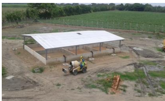
Foto 74. Lechos de secado reactor UASB. Archivo CVC, 2016
