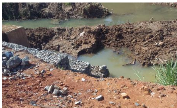
Foto 162. Muro en gavión. Archivo CVC, 2016
