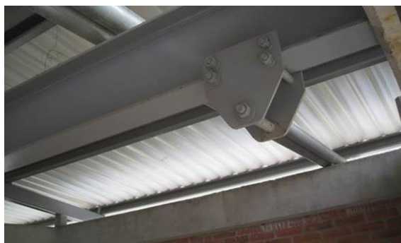
Foto 78 Estructura del malacate para manejar las bombas. Archivo CVC, 2016
