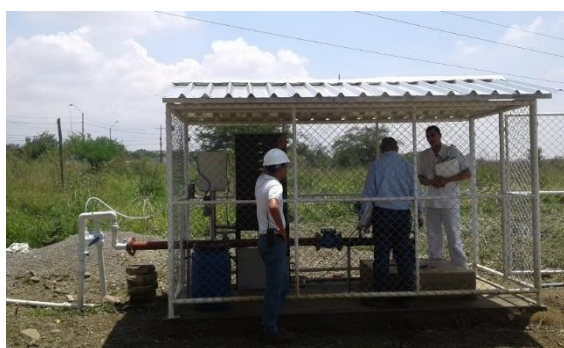
Foto 52 Visita para concesión de aguas subterráneas. Fuente: Grupo Recursos Hídricos, DTA. 2016
