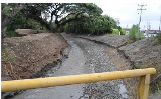
Foto 147. Enrocado Puente San Benito - Quebrada La Ribera - Municipio Tuluá. Archivo CVC 2016
