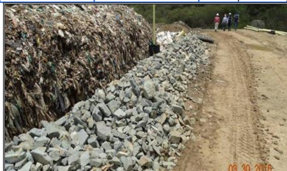
Foto 118. Frente de operación. Relleno sanitario regional Colomba – El Guabal. Archivo CVC 2016
