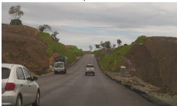
Foto 85. Cambio cobertura y uso del suelo, vía al puerto de Aguadulce, Buenaventura
