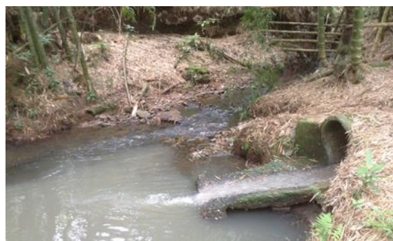
Foto 56. Descarga principal de la PTAR municipio de Caicedonia. Archivo CVC, 2016
