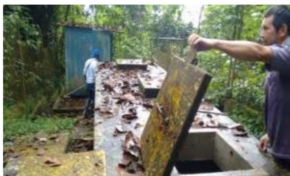
Foto 68. Apoyo y fortalecimiento de acueductos comunitarios, cuenca Rio Guadalajara. Archivo CVC 2016
