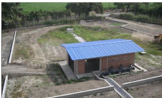
Foto 77 Protección estructura de pretratamiento y bombeo. Archivo CVC, 2016
