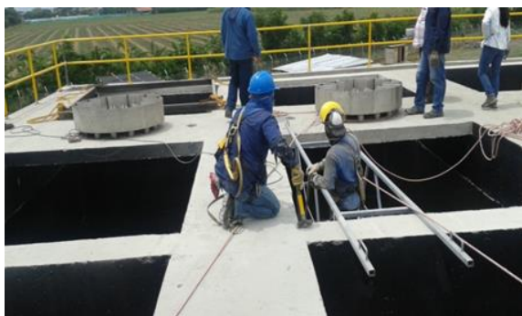
Foto 71. Montaje de tuberías – reactor UASB. Archivo CVC, 2016
