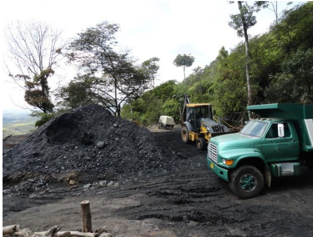
Foto 4: patio de acopio seleccionado para cargue directo a volqueta.
