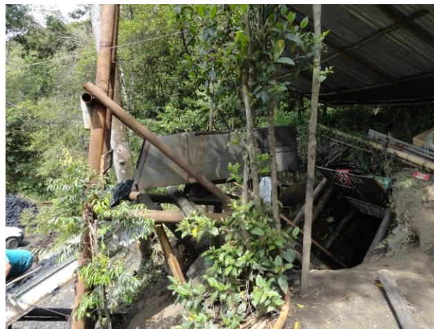
Foto 3: Skip que transporte material por la diagonal de la parte interna a superficie
