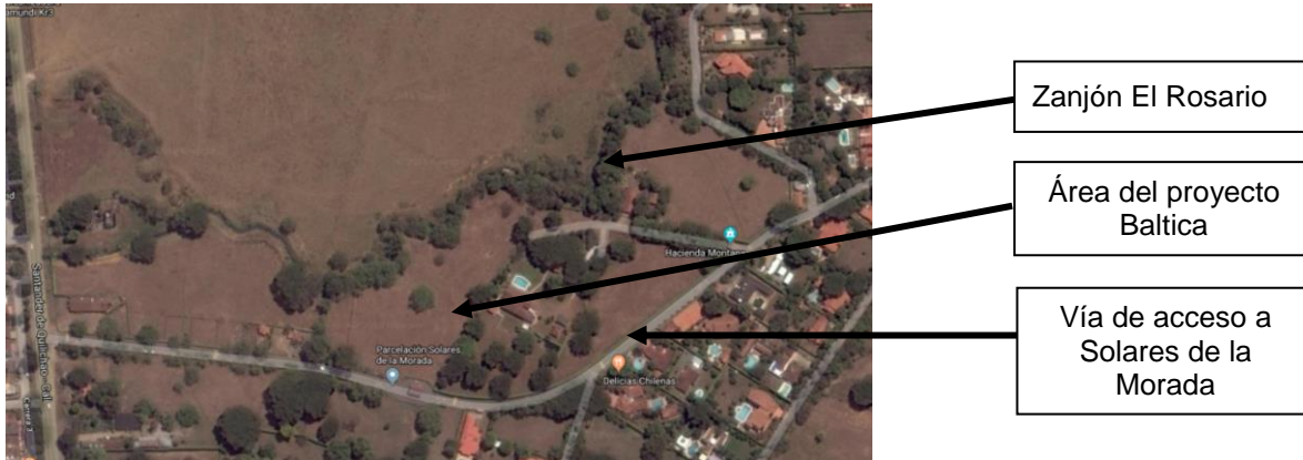
Imagen 1. Vista general del área del proyecto BALTICA, entre la vía de acceso a Solares de la Morada y el Zanjón el Rosario
