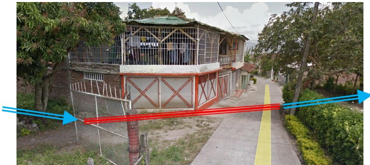
Foto: montaje situación del predio en 2013 donde ya se había construido la tubería bajo la vivienda
