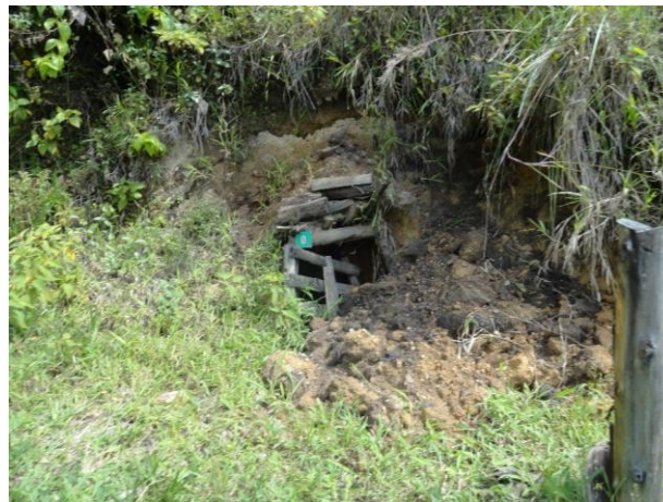
Foto 10: bocaminas clausuradas, de trabajos ilegales.
