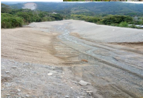
Mantenimiento del cauce realizado por el Municipio
