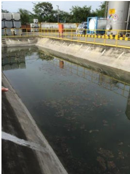
Imagen ¡Error! solo el documento principal.. Piscina de contención de AkzoNobel Pulp and Performance Chemicals S.A.S
