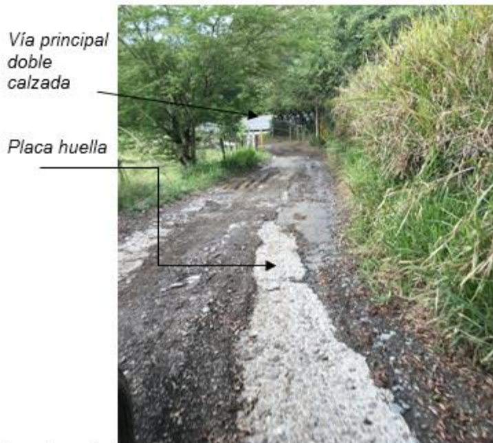
Foto 6: construcción de placas huellas para acceso a la mina y evitar desplazamiento de material a la vía principal
