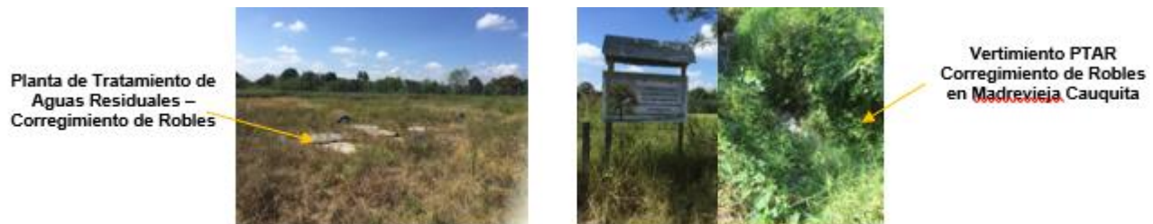
Imagen 1. Planta de Tratamiento de Aguas Residuales Corregimiento de Robles
