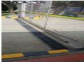
Imagen 3. Evacuación de aguas lluvias canaleta zona de la portería de AkzoNobel Pulp and Performance Chemicals S.A.S
