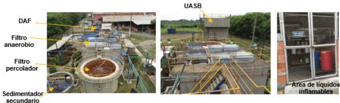
Imagen 1. Sistema de Tratamiento de Aguas Residuales Domóticas y No Domésticas de Comestibles Aldor S.A.S.
