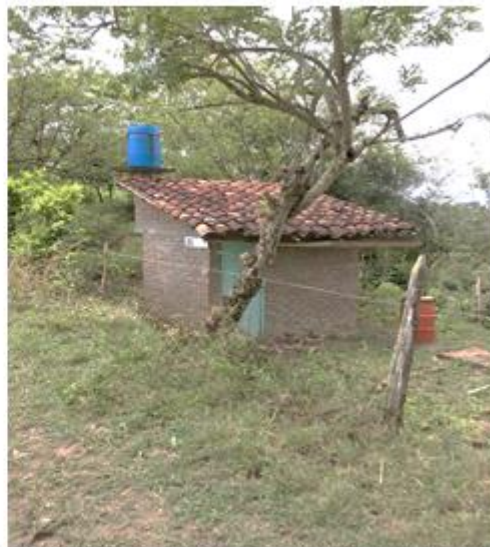
Foto 8: unidad sanitaria construida con tanque de almacenamiento de agua lluvia para su funcionamiento
