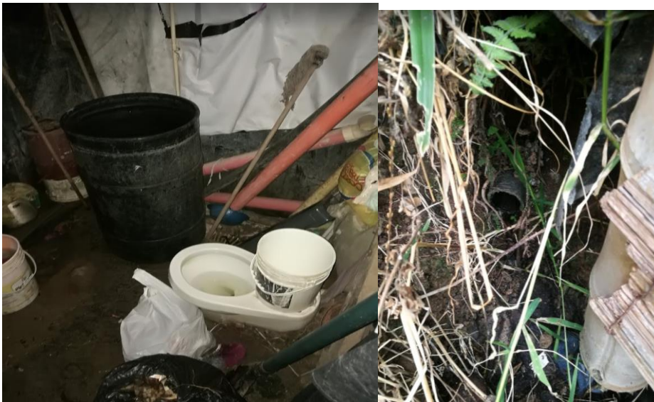
Foto 1 y 2: pecuarias condiciones de salubridad con el vertimiento de sanitarios a tres metros de las viviendas y con vertimiento a campo abierto, contaminación al suelo y a drenajes naturales secos.
