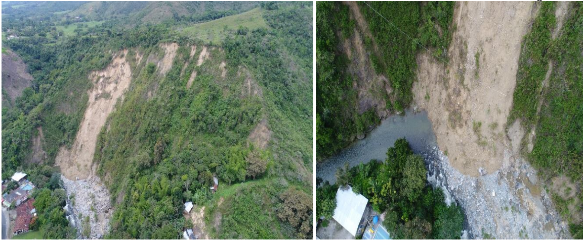
Fotos 1 - 2. Se observa el sitio donde se localiza el proceso erosivo y la pérdida de capacidad hidráulica del cauce por el depósito de materiales
