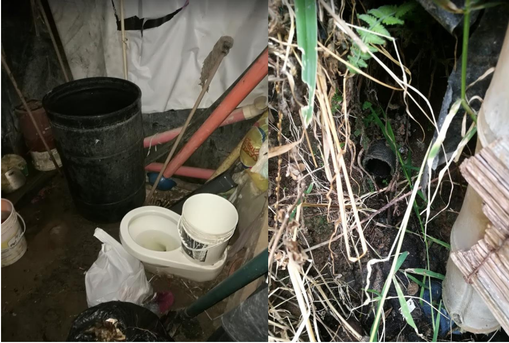
Foto 1 y 2: pecuarias condiciones de salubridad con el vertimiento de sanitarios a tres metros de las viviendas y con vertimiento a campo abierto, contaminación al suelo y a drenajes naturales secos.
