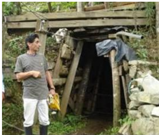
Foto 59: bocamina en construcción 1 A.
