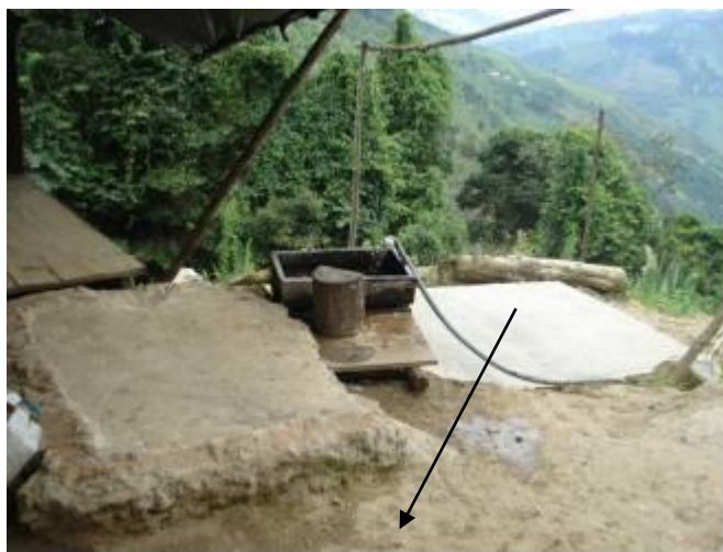
Foto 60: Bases de concreto para ubicación de mesas concentradoras.
