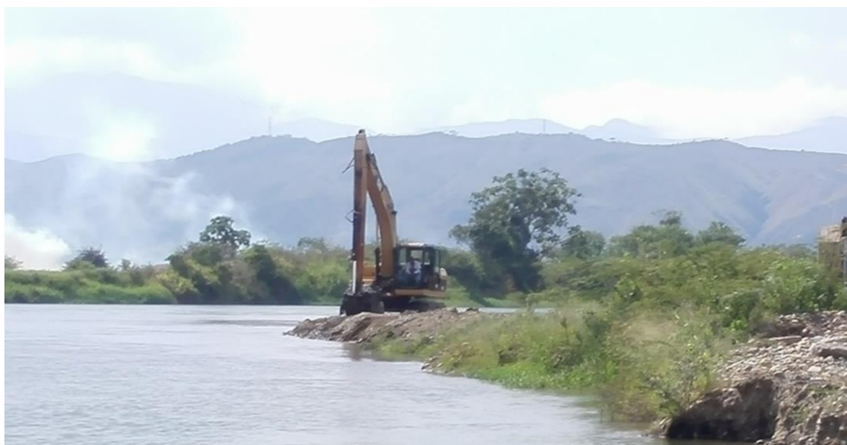
Foto No. 1- Se observa la retroexcavadora en el sitio de confluencia del río Timba al río Cauca
