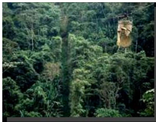
Foto 3. Paso tarabita entre bocaminas de La Victoria, atravesando el río guabas.
