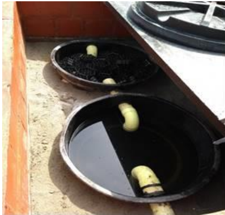
Foto 5. Cámara de inspección.
