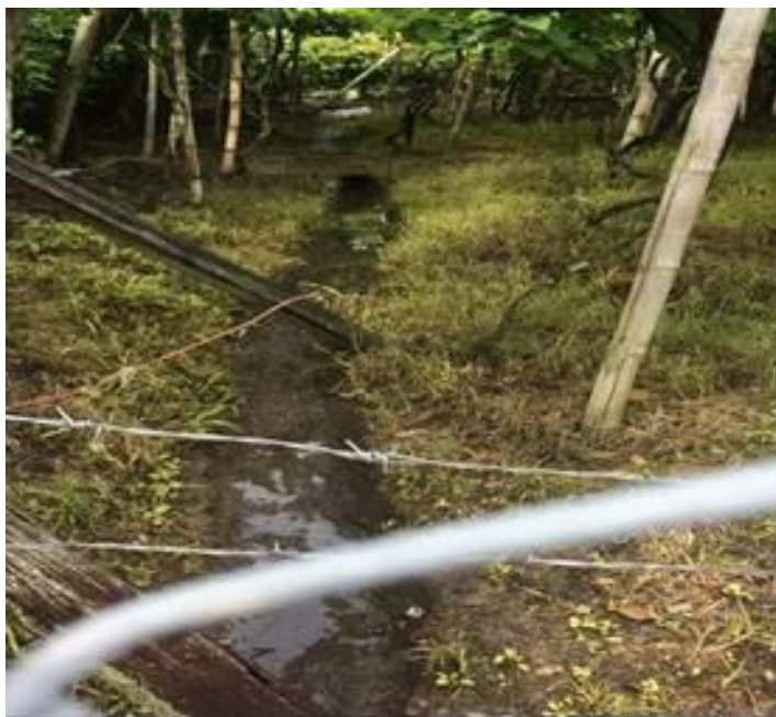
Foto 3. Tubería de transporte aguas lluvias.
