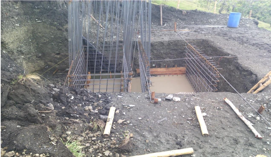
Obras constructivas de los sedimentadores de Planta de Potabilización Corregimiento de Mediacanoa.
