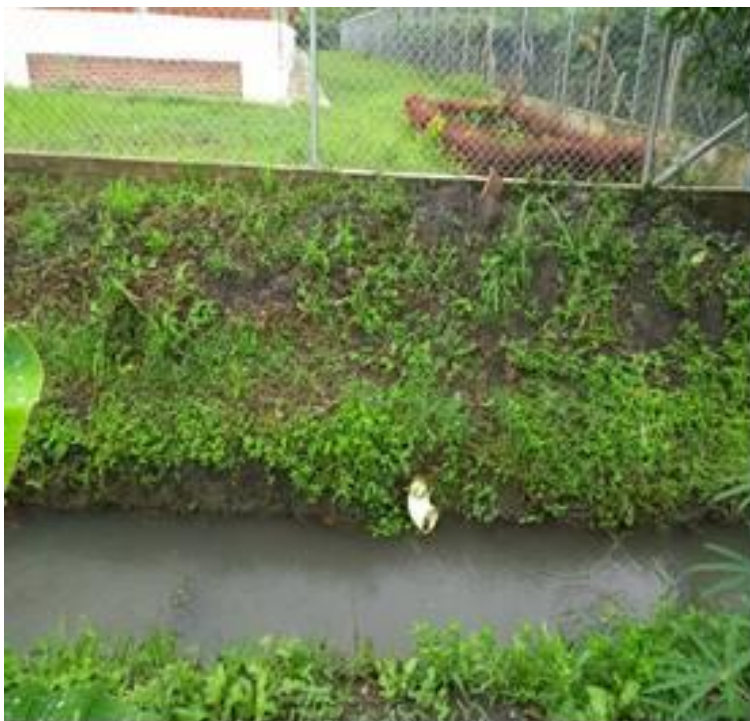
Foto 12. Punto de vertimiento STAR dos.
