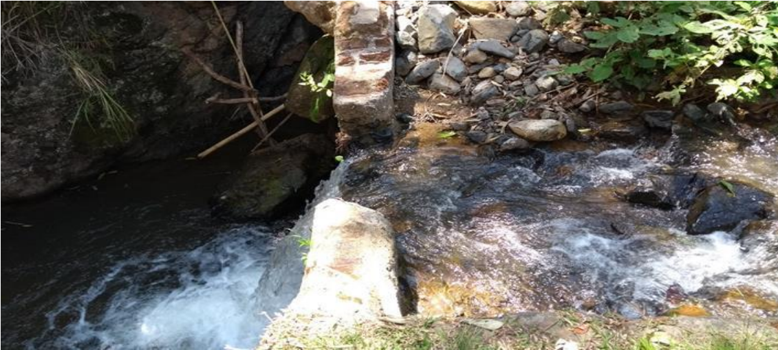
Sitio propuesta para mejoramiento de la obra de captación.
