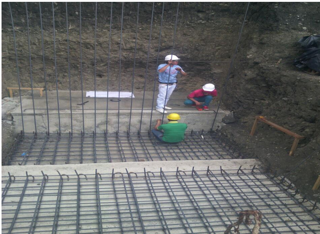
Mejoramiento de la Planta de Potabilización Entradas de las aducciones Chocho.
