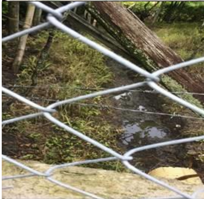
Foto 13. Sistema de tratamiento de residuos Sólidos de la bodega
