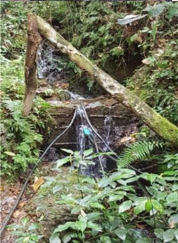
Figuras 6 y 7. Imágenes de la cortina que se ubica sobre el lecho del afluente hídrico donde se realiza la captación de agua.
