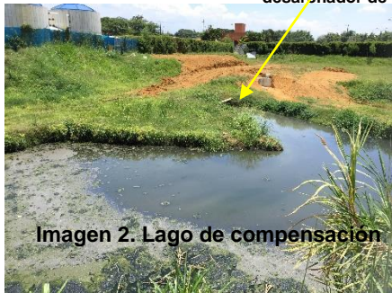
Tubería que conecta cámara de excesos del desarenador de la PTAR
