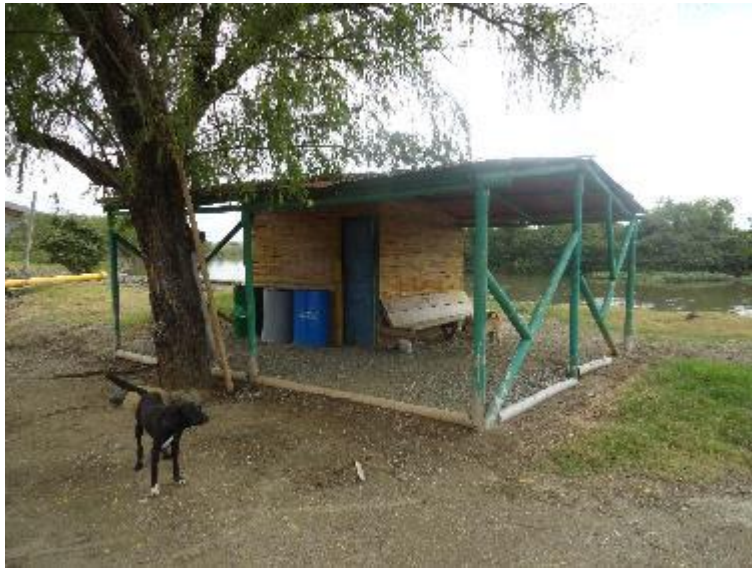
Foto No 3: ramada para resguardo de maquinaria menor y de trabajadores.
