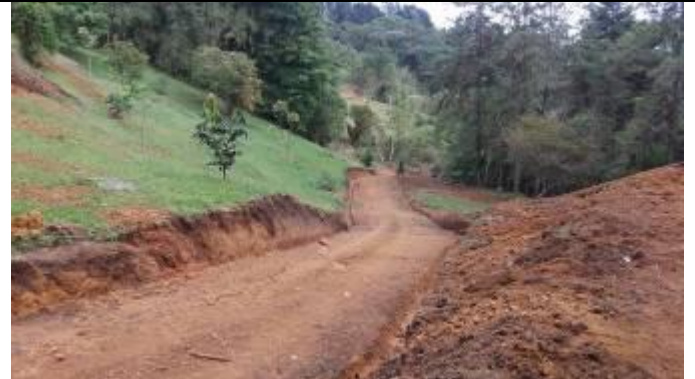
Foto 2. Apertura de vía
