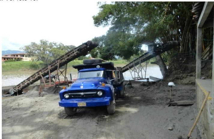
Foto No 10: patio de acopio con bandas transportadoras.
