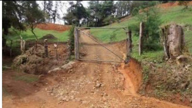
Foto 1. Apertura de vía
