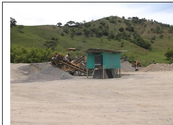
Foto 9. Al fondo se observa la retroexcavadora
