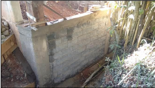
Fotos: Construcción de muro en concreto y bloque – Septiembre de 2016
