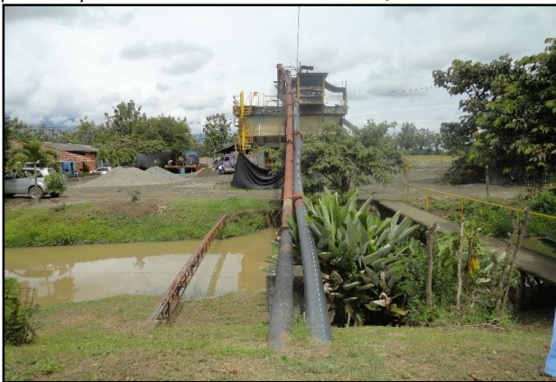
Foto No 13: Vista del canal del RUT y de la tubería proveniente de la draga que permite la descarga en el tanque elevado. Junto a esta la antigua tubería metálica.
