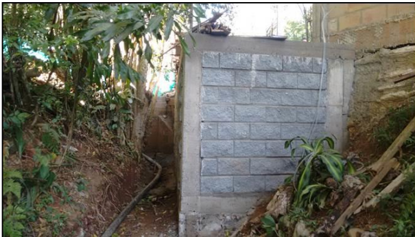
Fotos: Construcción de muro sobre cauce de escorrentía natral – Septiembre de 2016
