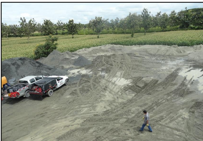
Foto No. 10. Vista del patio de acopio superficial, desde la parte superior del tanque elevado.
