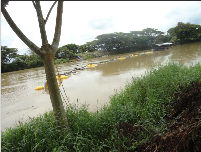
Foto No 14: draga de succión en el río con flotadores para la tubería
