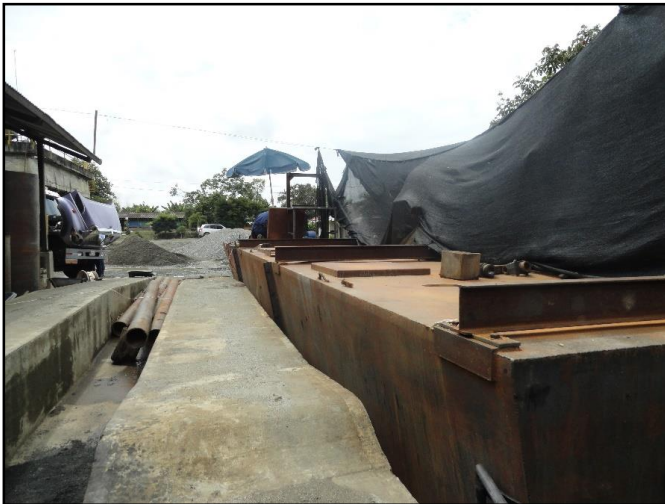
Foto 6: Cárcamo y construcción de draga de succión.
