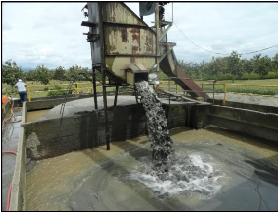
Foto No 12. Tanque elevado visto desde su parte superior. El canal de la derecha corresponde al sitio por donde se desvía el material vegetal.
