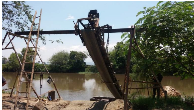
Foto 2. Se observa el patio de acopio y la banda transportadora
