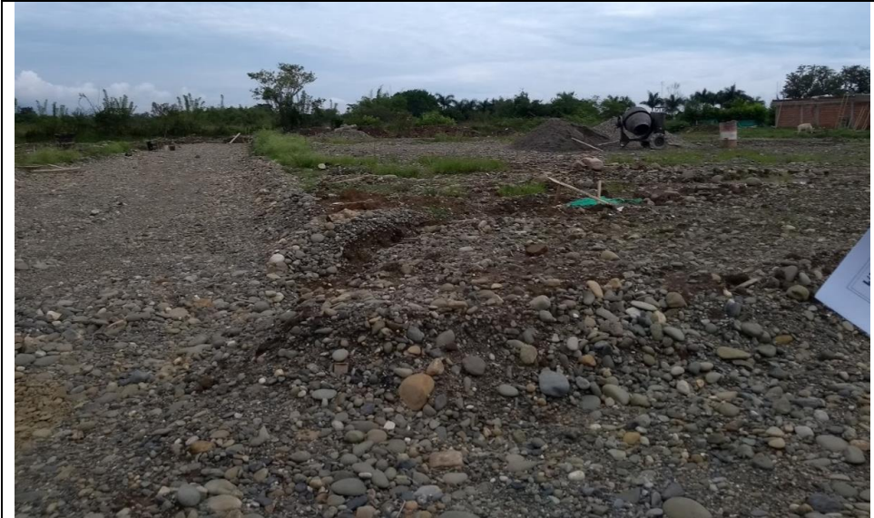
Figura 13 Predio con excavaciones y presencia de material pétreo.
