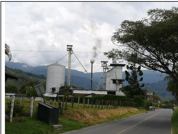
Vista externa de la planta y de la chimenea de la caldera Nebraska
