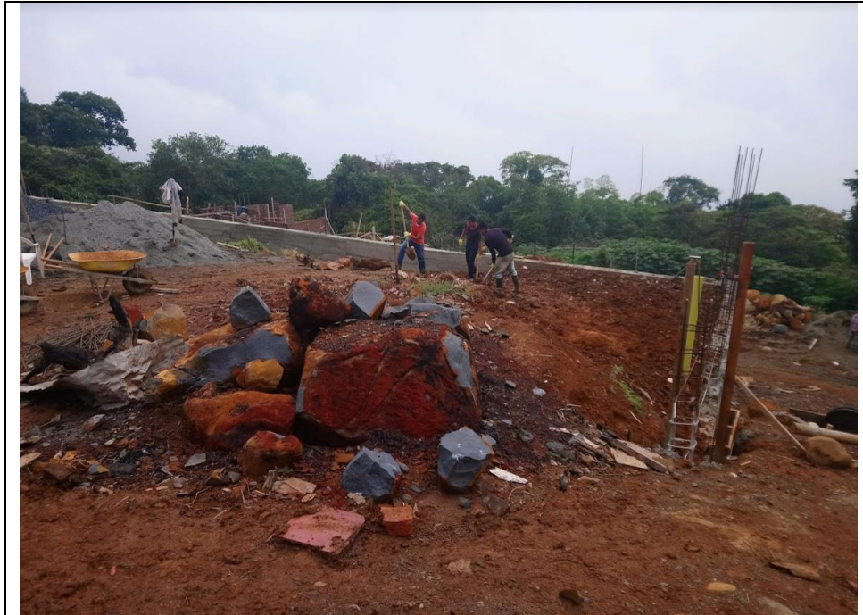
Figura 4 Actividades de excavación y relleno identificadas.
