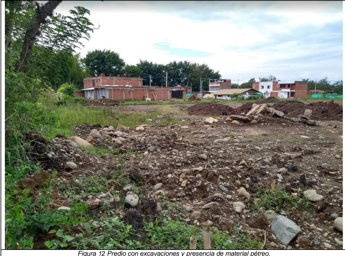
Figura 12 Predio con excavaciones y presencia de material pétreo.
