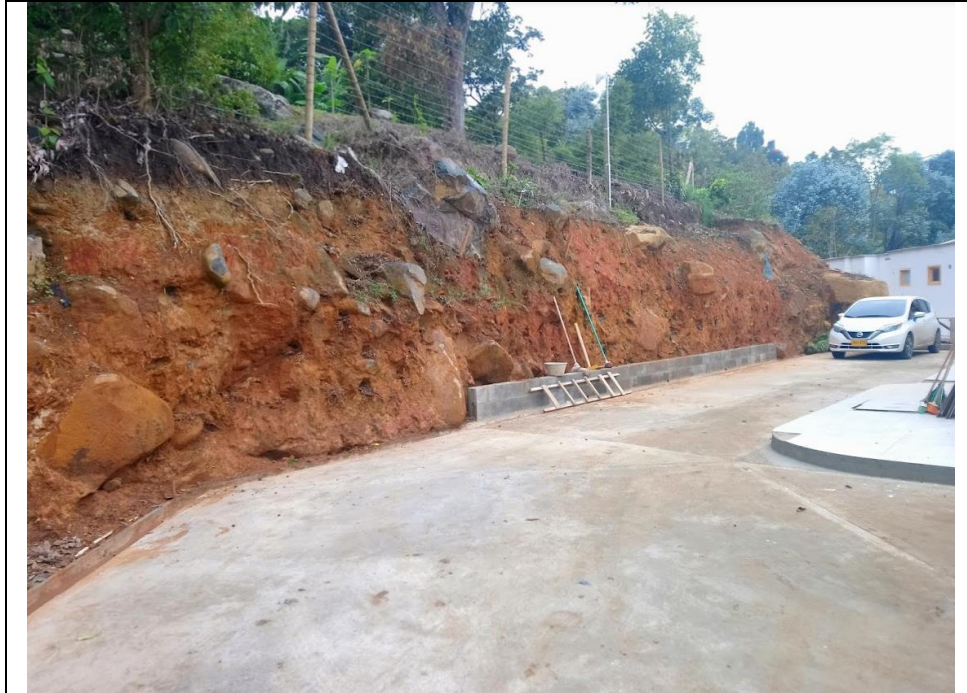
Figura 5 Corte parte alta del predio.
