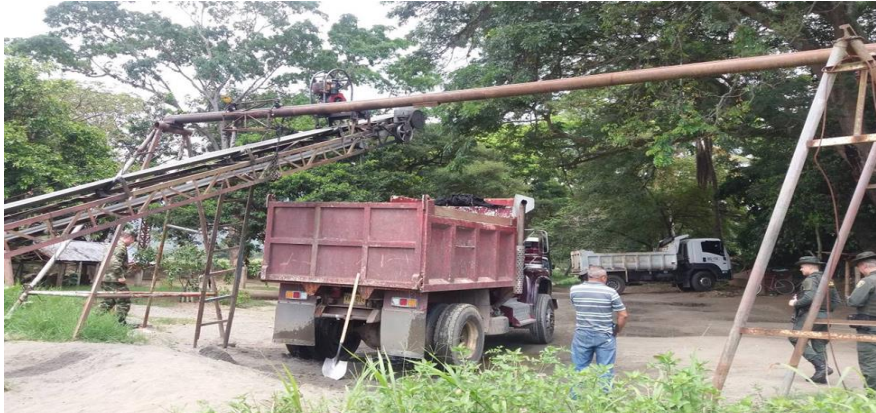
Foto 1. Se observa el proceso de cargue de la volqueta en el patio de acopio, mediante el uso de la banda transportadora y el vehículo a la espera del cargue.
