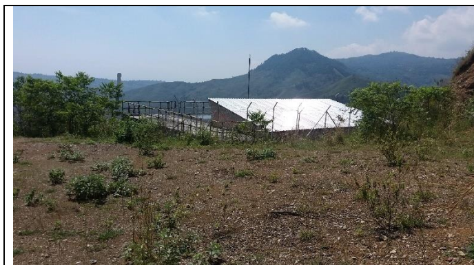
Foto 3. Area con la que comunica vía – tanque de la EPSA
