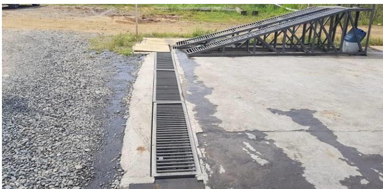
Foto 5. Canales con rejillas.
