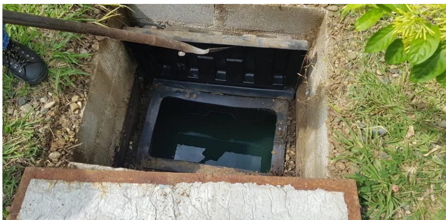
Foto 3. Tanque séptico prefabricado.
