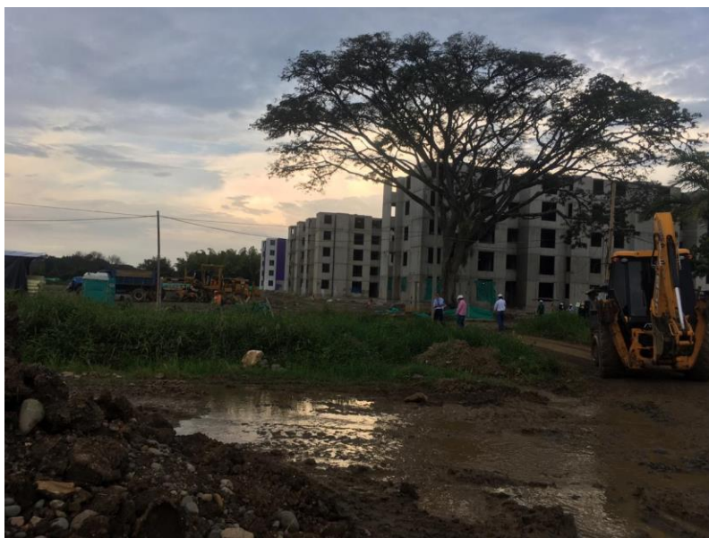
Foto 1. Área para construcción de la PTAR.
