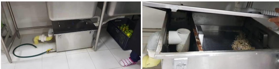
Foto 1 y 2. Trampa de grasas pre-fabricada en acero inoxidable.
