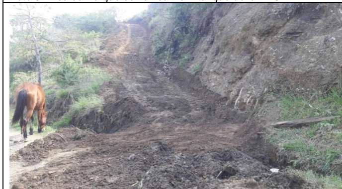
Foto 5. Intervención de la vía
