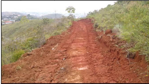
Fotos: Apertura de vía predio del señor Julio Andrés Varela - Noviembre de 2016
