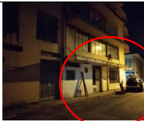
Foto No.2: Sitio donde se encuentra la planta eléctrica, que genera ruido.
