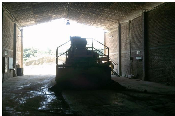
Foto 1. Una trituradora de capacidad 13-15 Ton/H,
