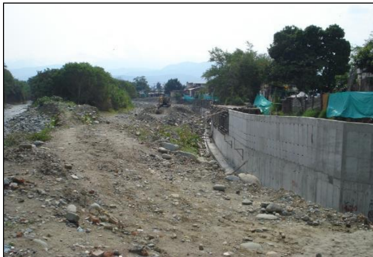
Foto 2: Muro de protección marginal construido dentro del polígono EAN-092. Fuente foto del año 2012.
