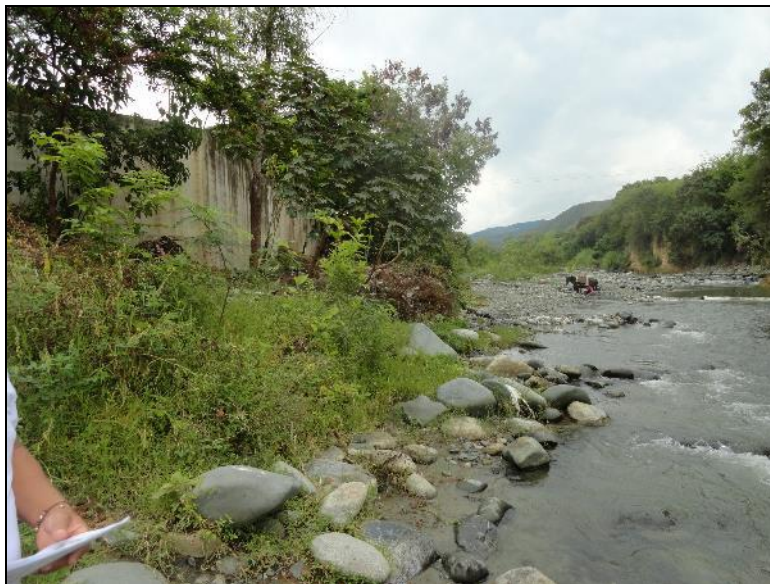
Foto No 3: Vista del muro, febrero de 2019.
