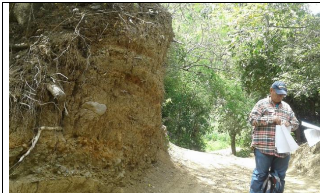
Imagen 4. Talud de la vía
