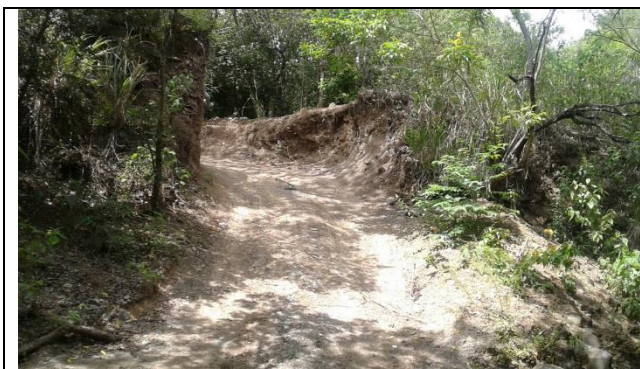
Imagen 2. Vía de acceso
