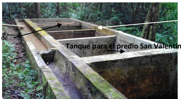
Obra de captación de la Derivación No.2
