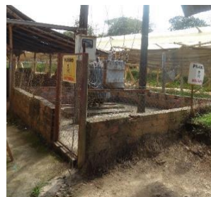
Foto No 7: tablero de control de energía
