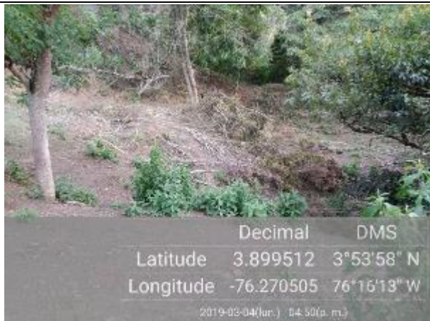
Foto No. 7: Adecuación de terreno
