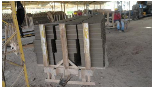
Foto No 5: vagoneta para transporte de material
