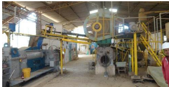
Foto No. 4. Máquina extrusora para moldear el ladrillo.
