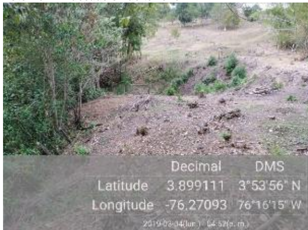
Foto No. 8: Adecuación de terreno
