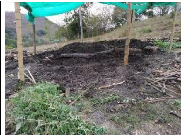
Foto No. 9: Construcción de carbonera
