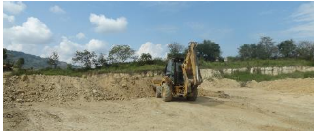
Foto No 10: patio de secado con retroexcavadora.
