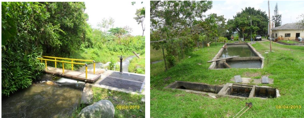
Foto 2 y 3. Conducción y Desarenador - Fuente: Acuavalle, 2013
