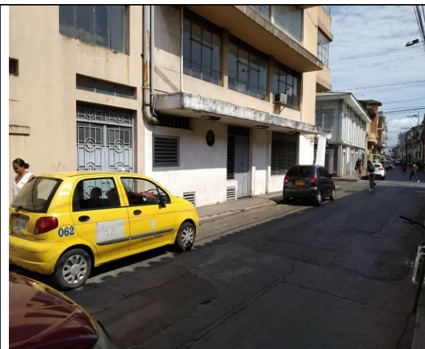
Foto No. 8: ubicación del generador eléctrico.
