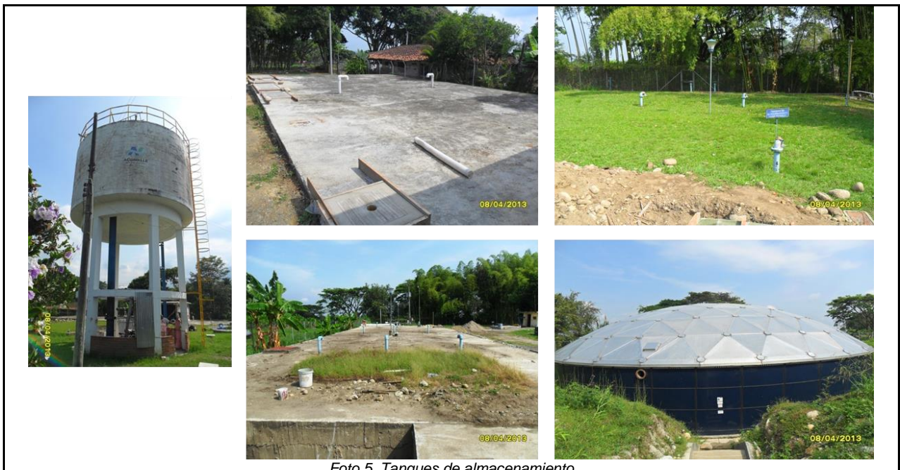
Foto 5. Tanques de almacenamiento Fuente: fotos ACUAVALLE, 2013
