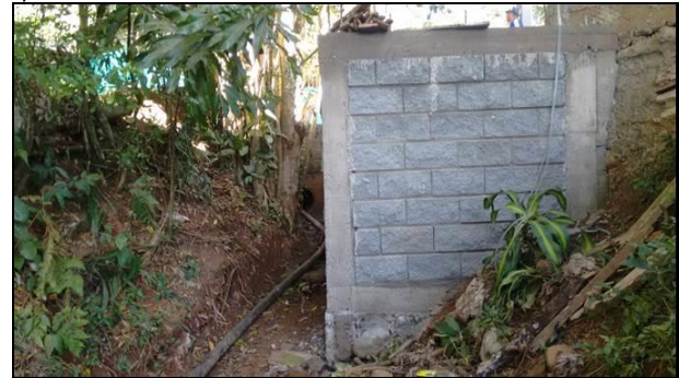
Fotos: Construcción de muro sobre cauce de escorrentía natral – Septiembre de 2016
