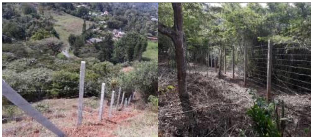
Foto 3-4. Instalacion de cerco.
