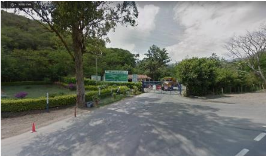
Fotografía 1 Área de Ingreso Relleno Colomba el Guabal
