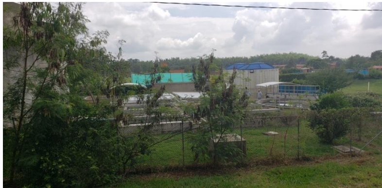
Imagen 2. Planta de Tratamiento de Aguas Residuales Domésticas
