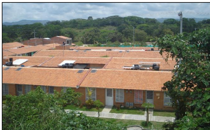
Foto No. 1: hacia el costado izquierdo de la planta de ladrillo se ubica la parcelación arboleda I, terminada y actualmente habitada.
