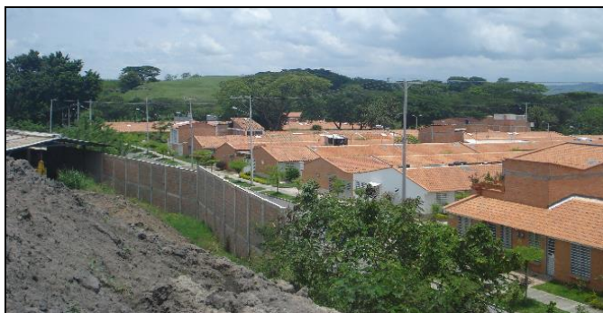
Foto No. 12. Material que debe ser debidamente conformado para evitar su desestabilización.
