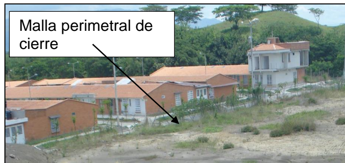
Foto 3: Malla de protección perimetral de la zona antigua de explotación, frente a la Parcelación villa arboleda II.
