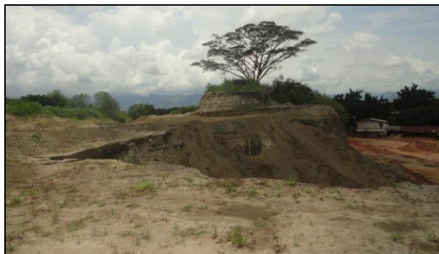
Foto No. 4. Vista del material apilado en los patios de acopio, el cual está viéndose afectado por fenómenos de erosión.
