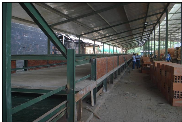
Foto No. 9: Horno de secado, actualmente en construcción.
