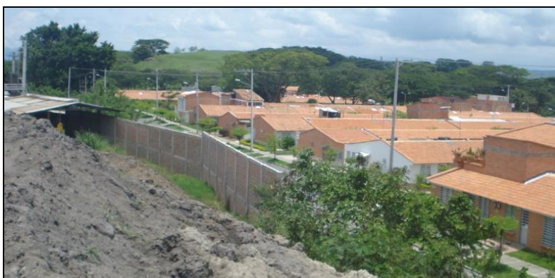
Foto 2: Muro que divide la vía de acceso de la urbanización con la infraestructura que sirve actualmente para la elaboración de ladrillo.
