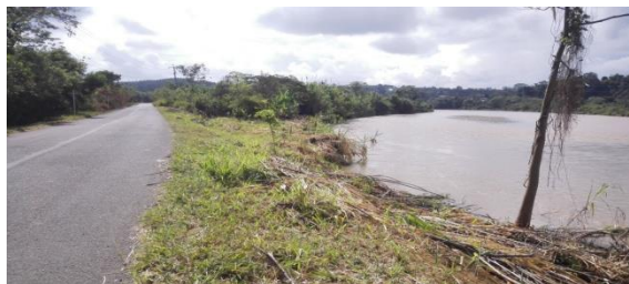
Foto No.2. Se observa el rastrojo bajo presente en la zona de la franja forestal protectora donde se construirán las obras para protección de la orilla. No se evidencian especies forestales
