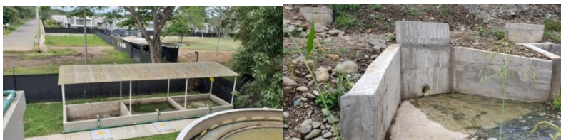
Fotos 7 y 8. Lechos de secado y cabezal de descarga al Río Pance.
