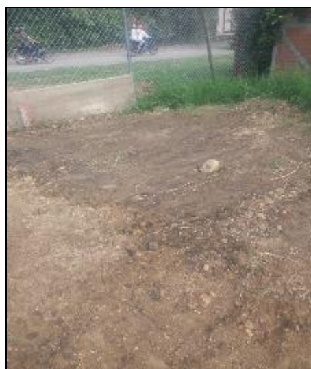
Foto 3. Campo de infiltración al suelo
