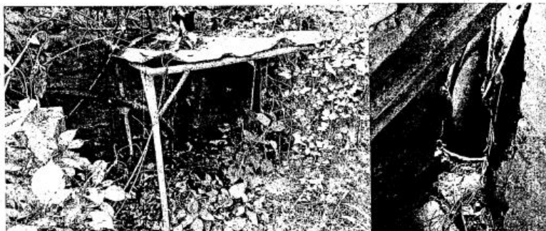
Foto 1 y 2 Estado del pozo Vo-22
