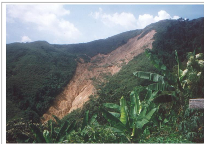
Figura 8. Vista del deslizamiento ocurrido en el año 2000 en el el sector La Luciana, aproximadamente 1 km. aguas arriba del polígono IDH-08171. Fuente Informe SGA-I-058-2000 de fecha del 25 de septiembre de 2000 (Grupo de Infraestructura de la CVC).
