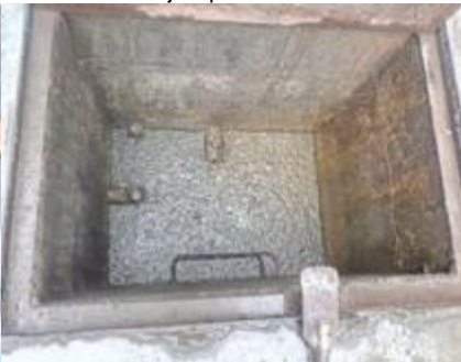
Cameras de separación de grasas colmatadas.
